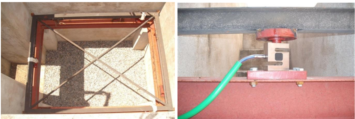
Figura 7. Instalação do suporte e das células de cargas.
