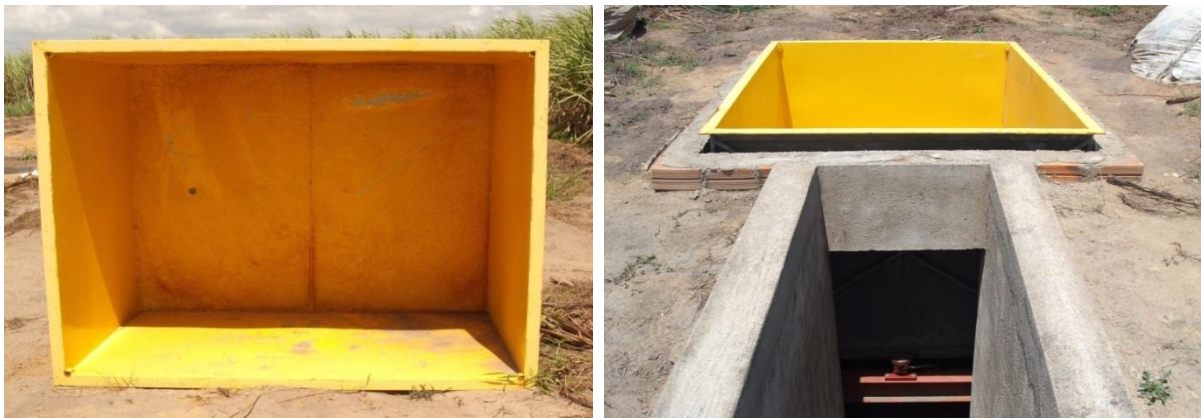
Figura 8. Caixa interna e instalação do lisímetro.
