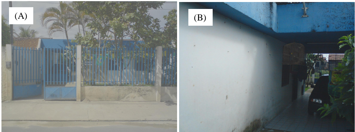
FIGURA 6 - Registros Fotográficos da Habitação 3. Fachada Frontal (A) e Fachada Lateral Esquerda (B).
