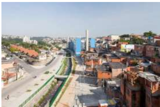
Figura 39 - Ao fundo, edifícios habitacionais, destinados às famílias removidas das áreas de risco.
