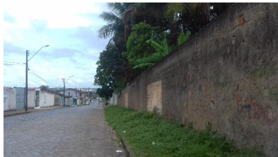
Figura 67 - Rua Augusto Quintela Cavalcante, lote onde será construída a praça.
