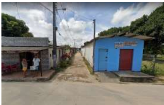
Figura 18 - Invasão de lotes no Loteamento Distrito Industrial
