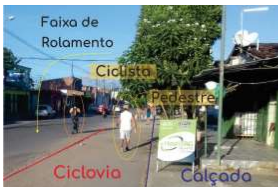
Figura 34 - Avenida Francisco de Melo. Calçada em Desnível ocupada por equipamentos de comunicação visual de estabelecimento comercial, pedestre caminhando na ciclovia enquanto o ciclista expõe-se na faixa de rolamento.
