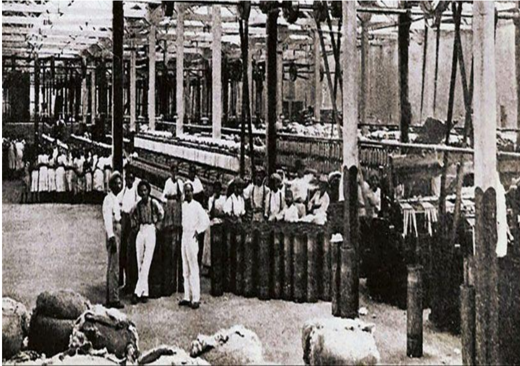
Imagem 5 – Seção de Tecelagem da Companhia de Fiação e Tecidos São Miguel
