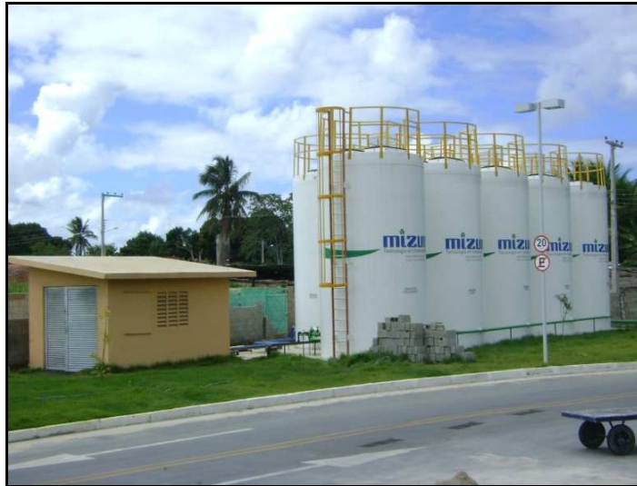
Figura 22: Estação de tratamento de esgoto do shopping Pátio Maceió
