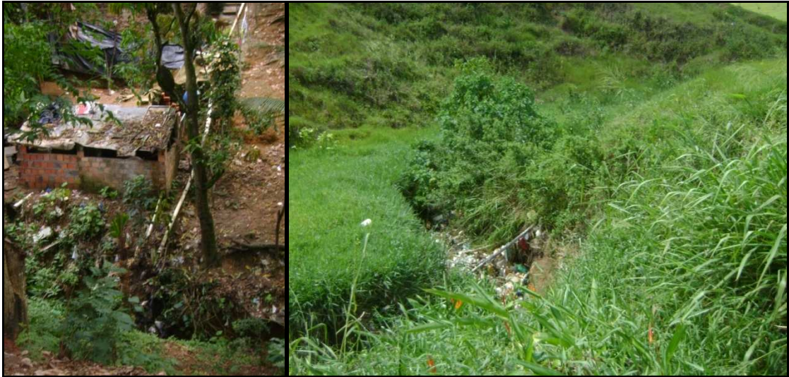
Figura 53: Encaminhamento do esgoto doméstico para vales no Benedito Bentes, Maceió – 2011
