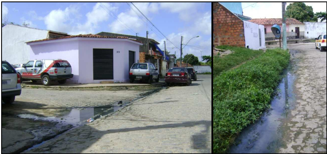
Figura 36: Esgoto doméstico na rua no bairro Vergel do Lago, Maceió – 2010
