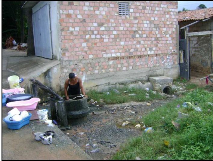
Figura 44: A utilização de poço e a presença de esgoto a céu aberto no Vale do Reginaldo, Maceió – 2010
