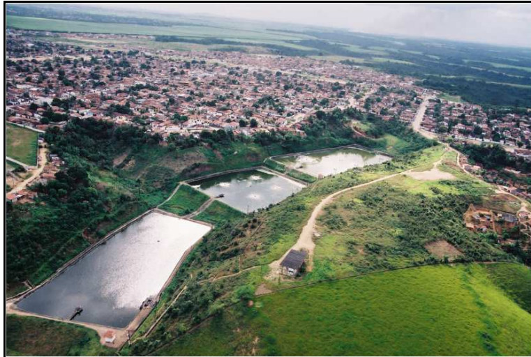
Figura 19: Lagoas de estabilização do Benedito Bentes, Maceió
