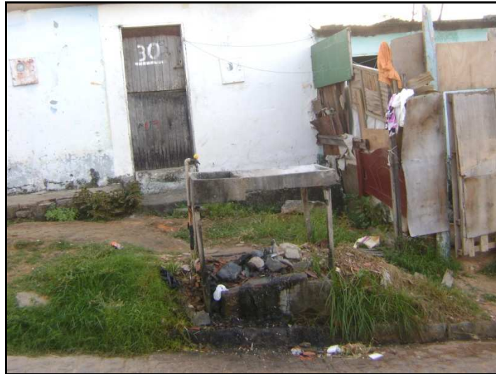
Figura 43: Lavatório na calçada sem qualquer sistema de coleta das águas residuárias no bairro Jacintinho, Maceió – 2010
