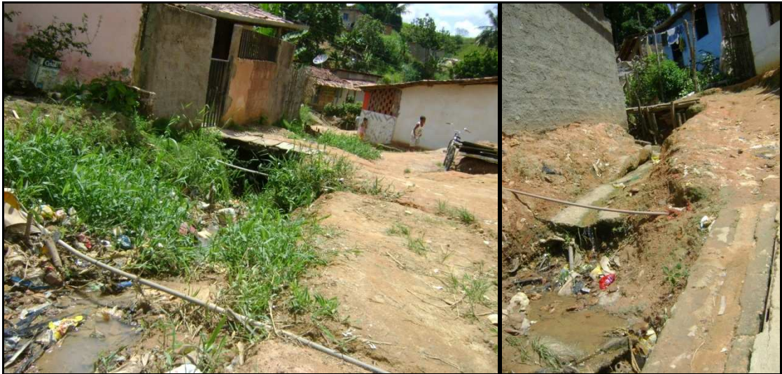
Figura 50: Tubulação de água passando em meio a esgoto a céu aberto, Maceió – 2011
