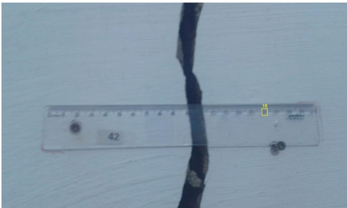
Figura 43 – Resultado da detecção que não foi suficiente para realizar o processo de medição da rachadura na casa 42
