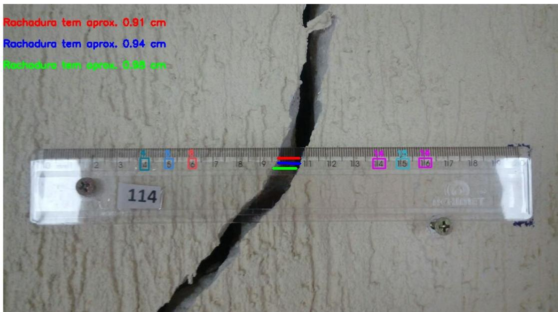
Figura 52 – Resultado da medição da rachadura encontrada na casa 114
