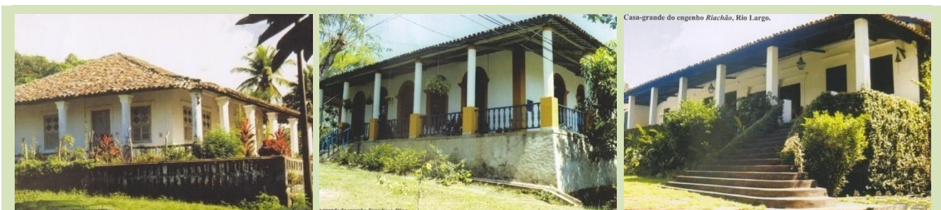
Quadro 10– Casas-grandes dos engenhos Salgado, Terra Nova e Riachão, casas avarandadas que marcam a paisagem rural em Pilar. Fonte: Calendário EdUFAL, 2004.
