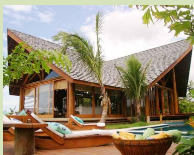
Figura 10 – Casa protegida da incidência direta dos raios solares e das chuvas através dos beirais.
