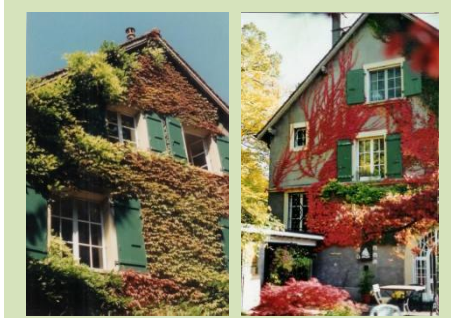
Figura 6 – Casa com vegetação caduca, durante o verão protege as paredes, ao passo que, no inverno, suas folhas caem, deixando o sol incidir sobre a superfície para aquecê-la. Fonte: idem.
