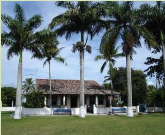
Figura 89 – Vista principal da Casa 1, vemos a vegetação distribuída – palmeiras e coqueiros defronte e árvores frutíferas ao lado e por trás. Fonte: Gabriella Peixoto, 2007.
