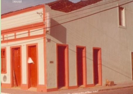
Figura 76 – Platibanda que suprimiu o beiral. A elevada inclinação do telhado propicia o uso do sobrado indicado pela janela na parte superior. Fonte: Ramalho, Bittencourt & Lins, 2003.
