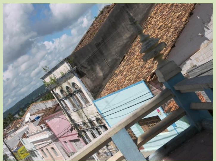
Figura 82 – Platibandas e detalhes incorporados pelas construções locais. Fonte: Gabriella Peixoto, 2008.
