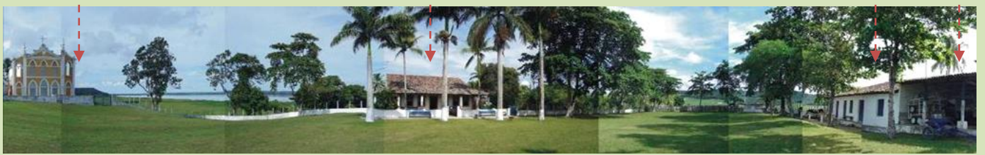
Figura 88 - Vista panorâmica do local, pátio circundado pelas edificações (da esquerda para direita): Capela; Casa-grande, Casa do morador, Moita. Observemos o espaçamento entre as edificações; as características do terreno e a distribuição da vegetação. Fonte: Gabriella Peixoto, 2007.
