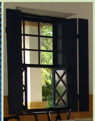
Figura 95 - Esquadria guarnecida com vidro, sendo a metade superior fixa e a inferior de abrir. Duas folhas cegas de abrir sobrepostas. Fonte: idem
