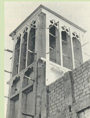
Figura 26 – O elemento de captação e ventilação. Fonte: Fathy, 1980, p. 132.
