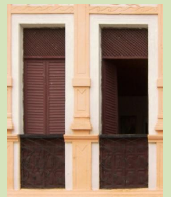
Figura 149 – Esquadrias da fachada: treliça, veneziana e parte cega servindo de peitoril. Fonte: idem.
