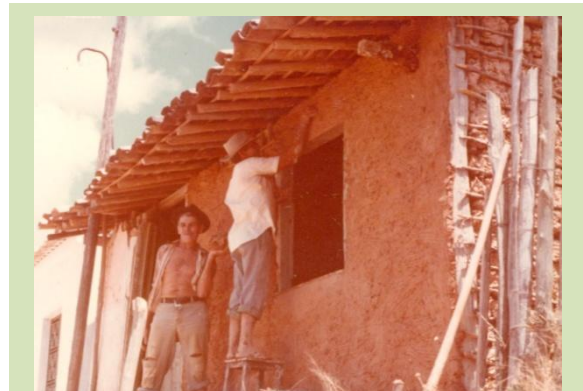
Figura 78 – A tradição construtiva da taipa de mão, perpassando gerações. Pilar. Registro de 1985. Fonte: Ramalho, Bittencourt & Lins, 2003.
