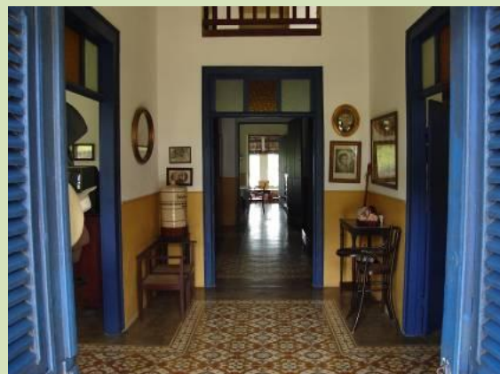
Figura 94 – Eixo do partido meia morada. Em primeiro plano, a porta de entrada com duas folhas com veneziana de abrir; Ao meio, portas com bandeiras em vidro colorido, ao fundo porta tipo holandesa 80 (ou porta-janela). Fonte: idem.
