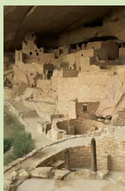
Figura 22 – Determinado período do ano a encosta abriga o povoado dos ventos, beneficiando-o com a massa térmica. Fonte: idem.
