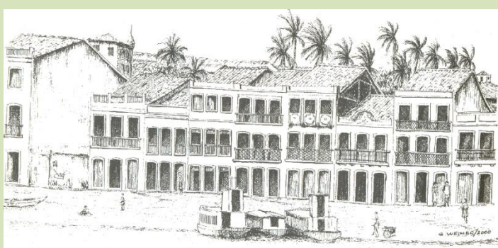
Figura 41 – O casario urbano aformoseando-se com platibandas e frisos. Penedo. Fonte: Weimer, 2005, p. 298.
