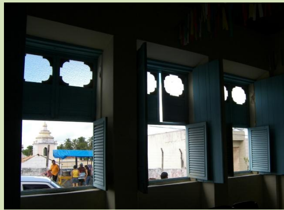
Figura 133 – Janelas da fachada principal vistas a partir da sala de receber. Fonte: Gabriella Peixoto, 2008.
