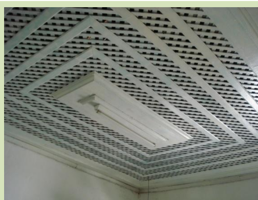
Figura 159 – Vista do forro treliçado. Fonte: idem.
