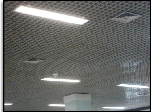
Figura 4-13. Luminária do tipo calha dupla.
