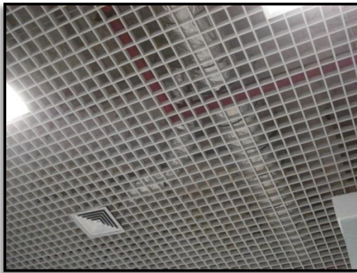
Figura 4-29. Teto colméia e tubulação diversa.
