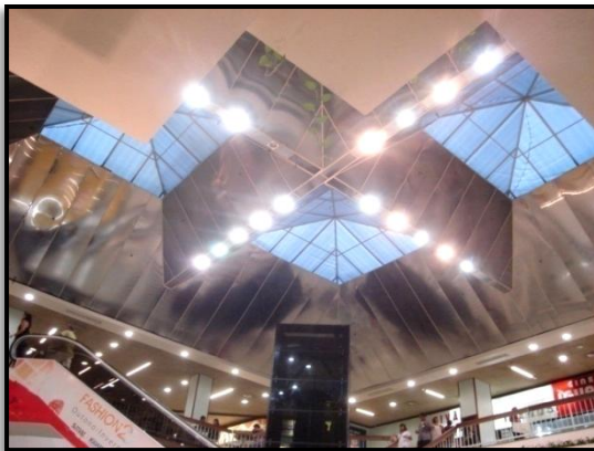
Figura 4-23. Abertura zenital composta por 4 domos.
