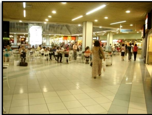
Figura 4-25. Sistema luminoso auxiliar.
