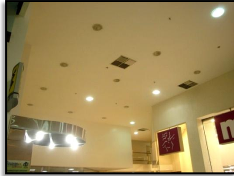
Figura 4-22. Detalhe do teto de entrada da A18.
