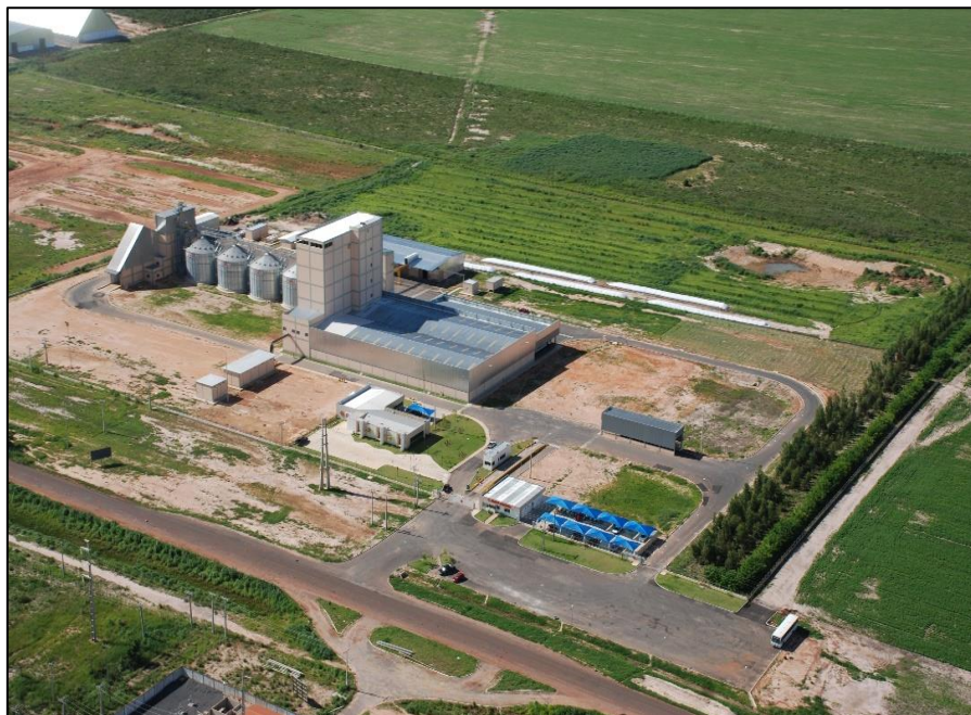
Figura 12-Vista área do complexo industrial do Grupo Coringa em Luís Eduardo Magalhães
