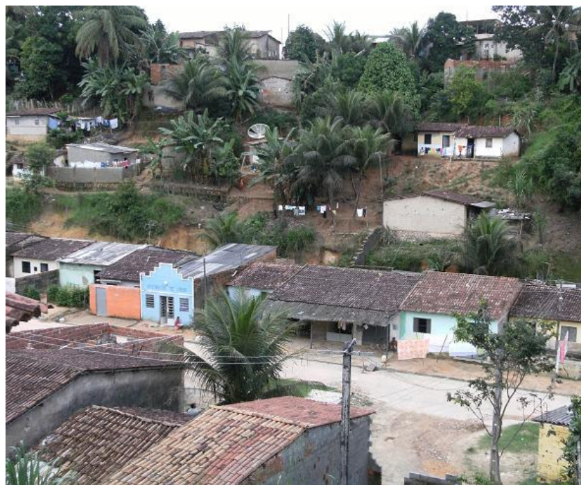
Ilustração 4.38: Via pavimentada da Grota da Alegria, 2009.
