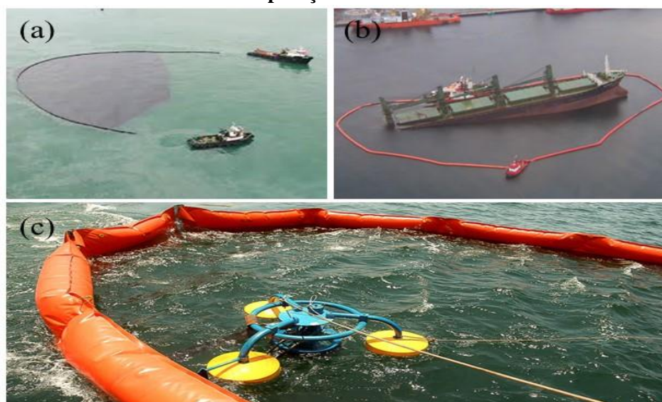
Figura 2 – Barreiras de contenção e coletores: (a) Aplicação de booms para delimitar e concentrar área de vazamento e (b) booms para contenção de óleo em torno do navio; (c) skimmer usado na recuperação de óleo nos limites dos booms .
