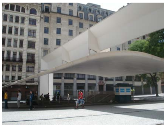
Fig. 152 - Praça do Patriarca - cobertura Foto: Claudio Bergamini - 2008
