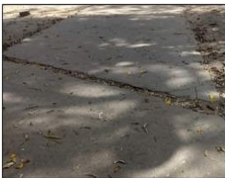
Foto 5 - Piso com rachadura encontrado no percurso da Biblioteca ao Bloco 18.
