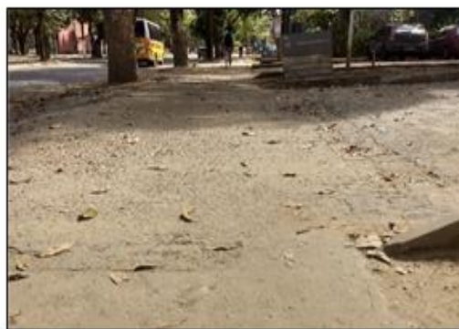
Foto 6 - Piso com falta de nivelção ausência de piso tátil e barreiras de proteção lateral.
