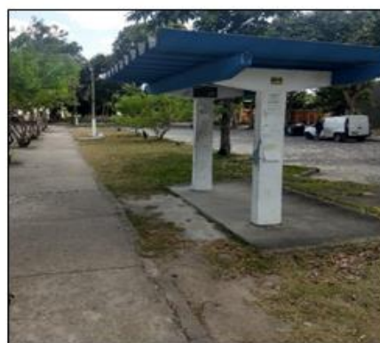
Foto 4 - Inacessibilidade no ponto de ônibus.
