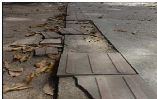
Foto 2 - Piso tátil direcional sem manutenção.
