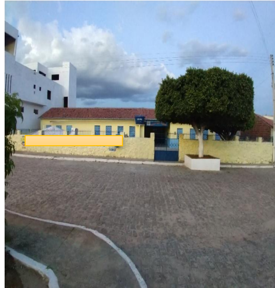
Figura 2- Fachada da instituição-campo
