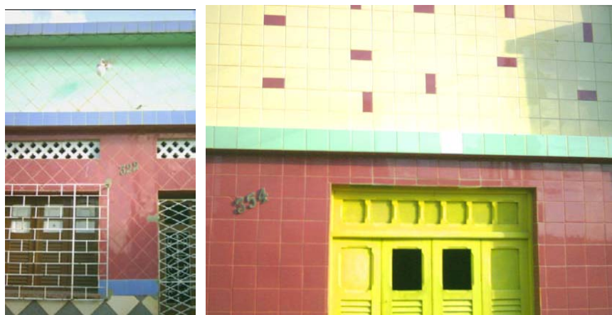
Figs. 14 e 15: Casas de fachadas azulejadas (Fonte: IP, 2005).
