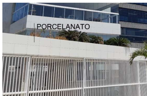
FIGURA 3.32 - Detalhe do material da fachada do Ed. Ana Lidya
