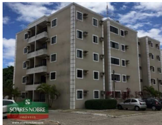
FIGURA 3.56 – Foto de um bloco de apartamentos do residencial Eco Vilares
