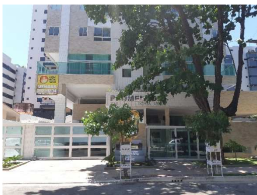
FIGURA 3.70 – Foto da calçada e portões de acesso ao Ed. Promenade
