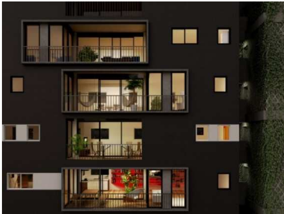
FIGURA 1.8 - Perspectiva do edifício Fidalga 727 / São Paulo
