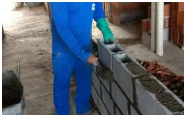
FIGURA 3.57 – Pedreiro na obra aplicando argamassa nos blocos de alvenaria estrutural
