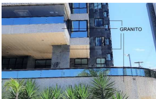
FIGURA 3.31 – Detalhe do material da fachada do Ed. Grand Classique
