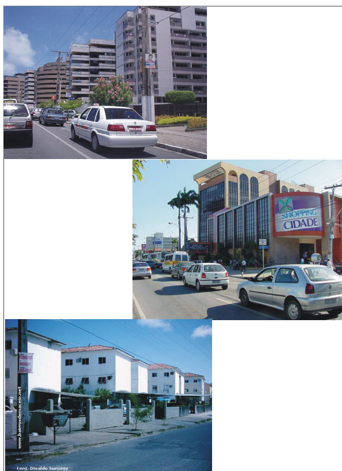
Figura 53 - Foto Orla marítima Bairro de Ponta Verde, Avenida Fernandes Lima, bairro do Farol, Conjunto Habitacional do bairro do Pinheiro, 2005.
