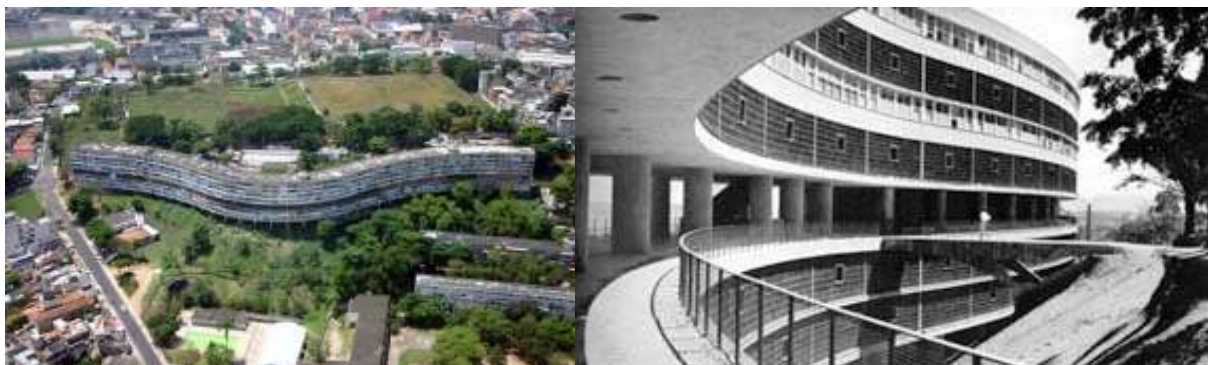
Figura 3.3 – Vista panorâmica (a) e detalhe da fachada do conjunto Pedregulho (b), São Cristovão, Rio de Janeiro, 1948.
