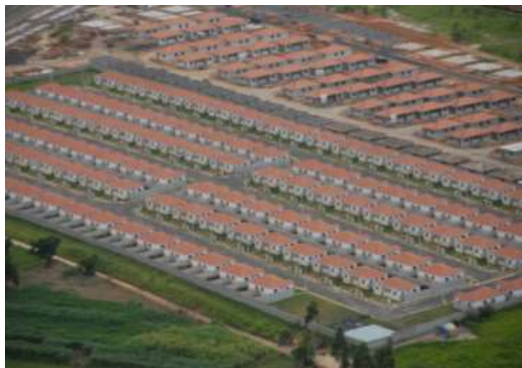
Figura 3.4 – Implantação do conjunto habitacional Sumaré I, em Sumaré, São Paulo.
