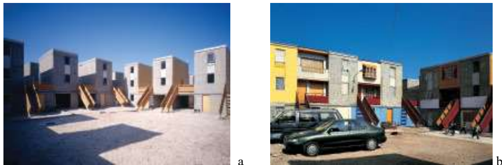
Figura 2.3 – Conjunto Habitacional Quinta Monroy, Iquique, Chile: fachada original, sem intervenções (a) e fachada depois da interferência dos moradores (b).
