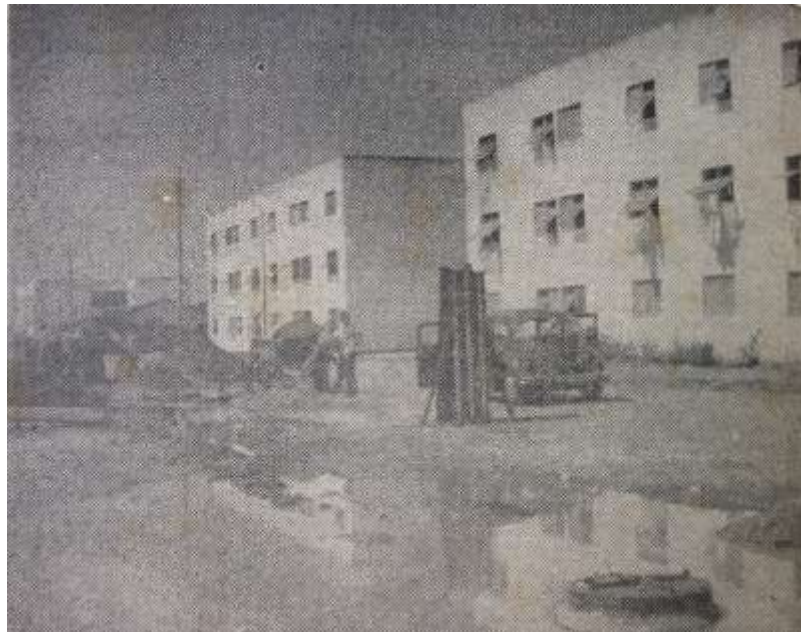
Figura 5.9 – Conjunto Castelo Branco II no bairro da Jatiúca: abertura de fossas.
