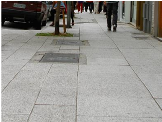
Figura 30 - Tampas de acesso sem saliências que provoquem desconforto ao pedestre
