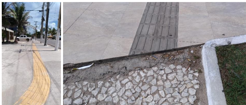
Figura 58 - Piso tátil direcional no segmento 3
