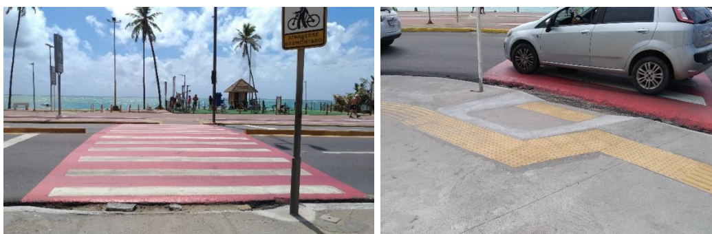
Figura 52 - À esquerda, travessia do segmento 2 e, à direita, travessia do segmento 3
