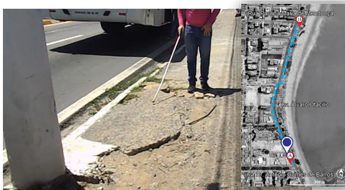
Figura 61 - Utilização do meio-fio como linha guia pelo voluntário
