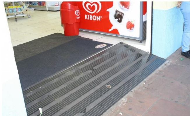
Figura 32 - Rampa de acesso à loja
