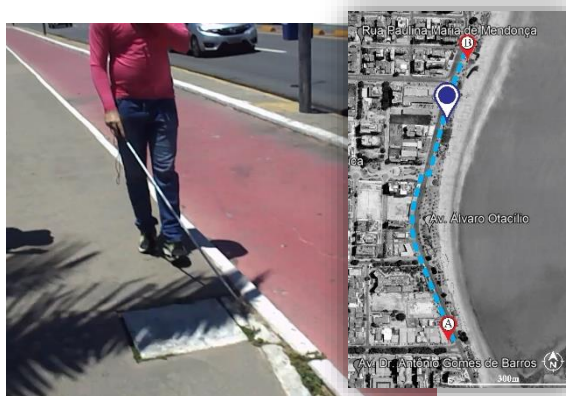
Figura 70 - Caixa de visita no caminho
