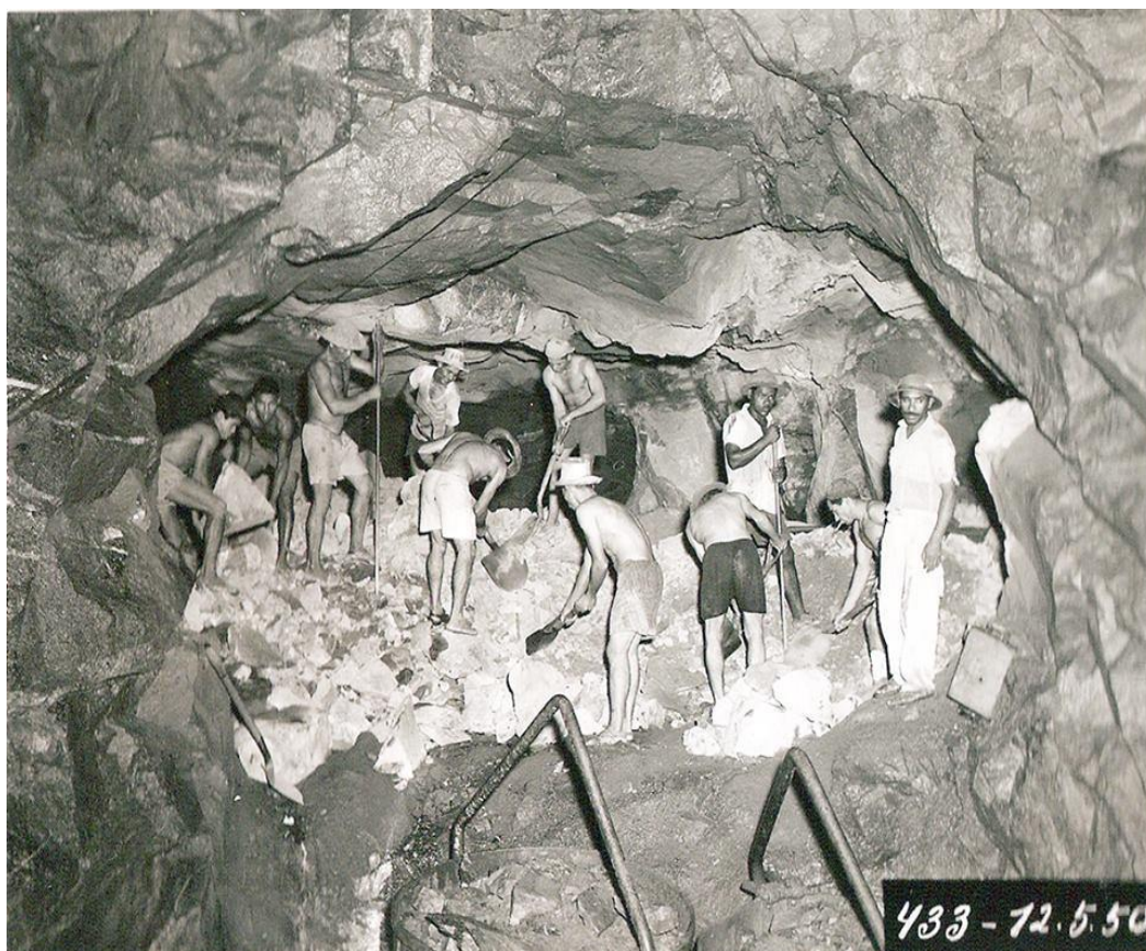
Imagem 02 – Trabalhadores no início da construção da Usina.
