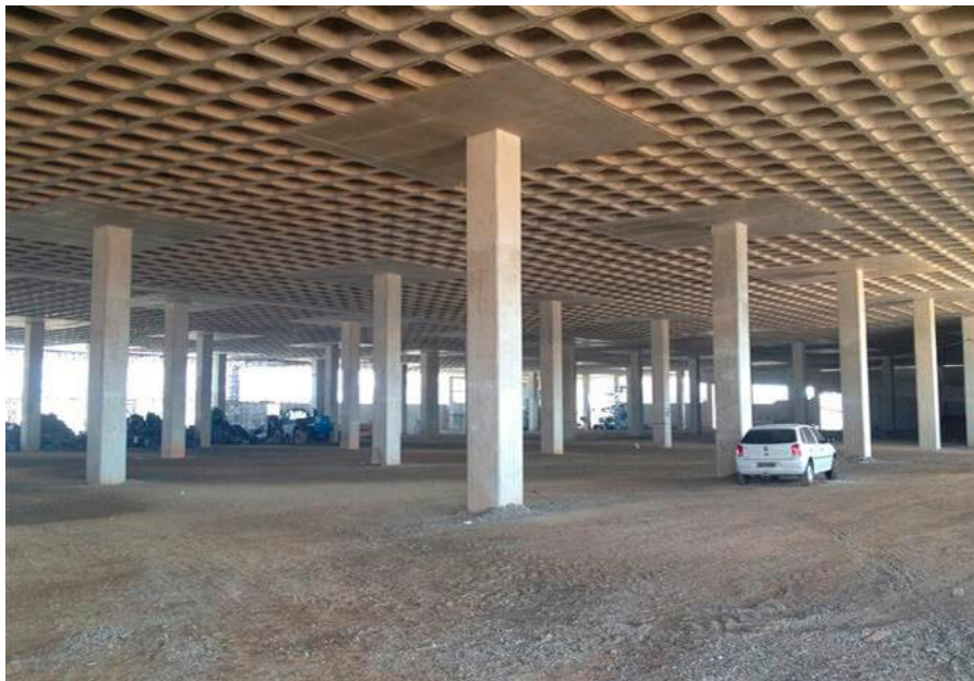
Figura 5 - Laje Nervurada em cubetas.
