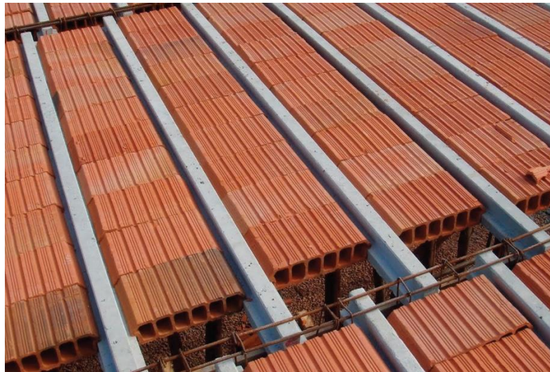
Figura 6 - Laje pré-moldada com preenchimento com blocos cerâmicos.
