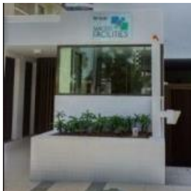
Figura 102 - Guarita (Ed. Maceió Facilities) Fonte: Google maps
