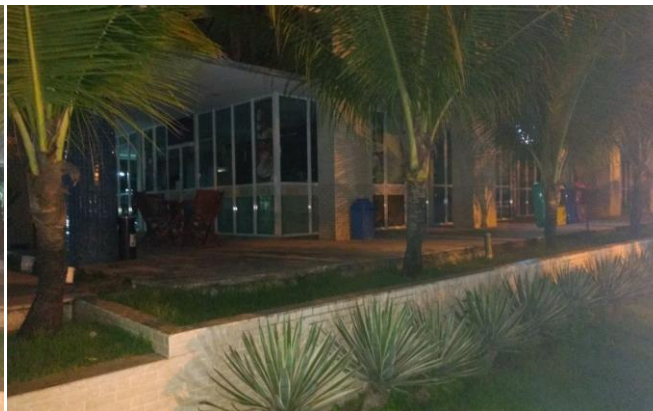
Figura 93 – Desnível de 50 cm em relação à calçada no acesso rua José Pontes de Magalhães Fonte:A autora
