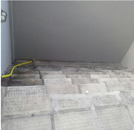
Figura 60 - Antigo acesso atualmente isolado Ed.Fiordes Fonte: A autora
