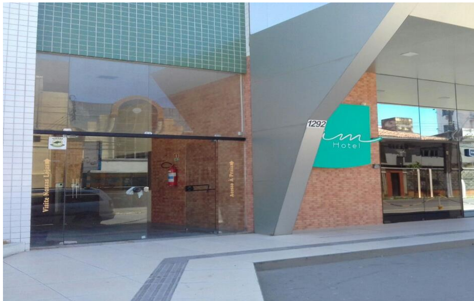
Figura 42 - Acesso pela Rua Jangadeiros Alagoanos da galeria Art Center Pajuçara Fonte:A autora
