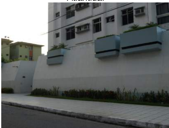
Fig.3.47- Presença de muro no edifício Atlântida.
