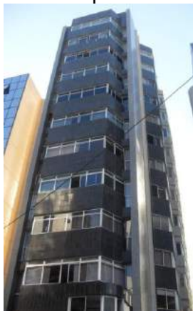
Fig.3.78- Edf. Status, varandas com saques.
