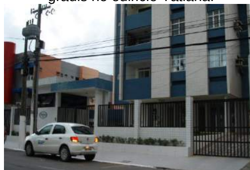
Fig.3.50- Presença mista de muro e gradis no edifício Tatiana.
