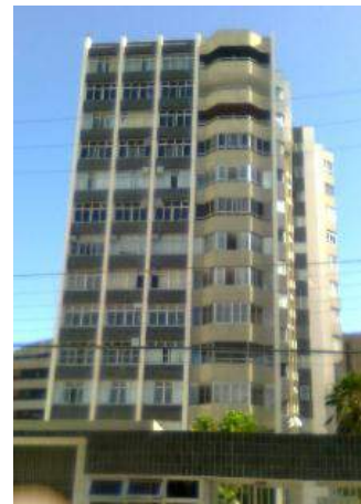
Fig.3.108- Edifício Barroca (1973), base e corpo.
