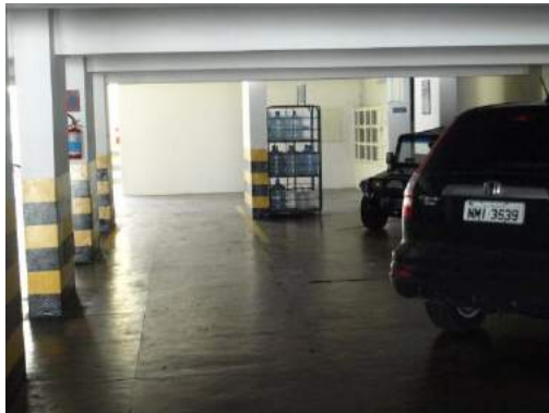
Fig.3.13- Subsolo do edf. Solar Graciliano Ramos.
