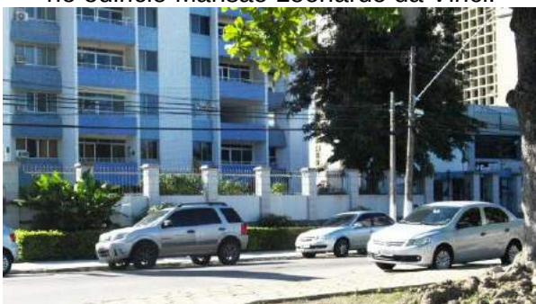
Fig.3.49- Presença mista de muro e gradis no edifício Mansão Leonardo da Vinci.
