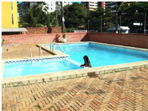
Fig.3.156- Piscina no pavimento térreo do edf. Costa Verde
