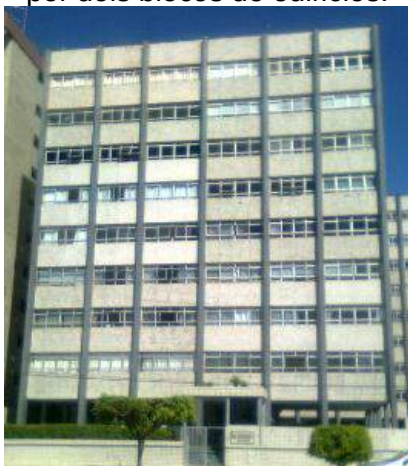
Fig.3.1- Edifício Jangada constituído por dois blocos de edifícios.
