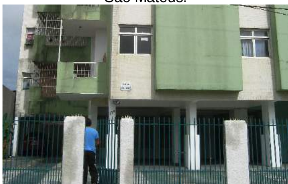
Fig.3.45- Presença de gradis no edifício São Mateus.
