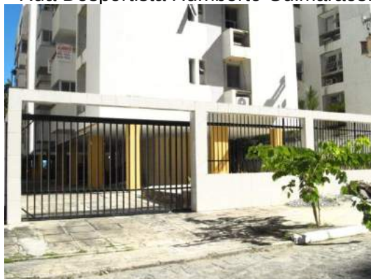
Fig.3.30- Acesso ao edf. Fragata pela Rua Desportista Humberto Guimarães.
