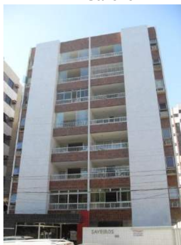
Fig.3.103- Varanda confinada no Edf. Saveiro
