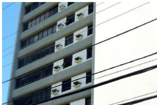
Fig.3.128- Detalhe da Fachada frontal do Edf. Lagoa Mar, revestida em concreto na cor ocre.
