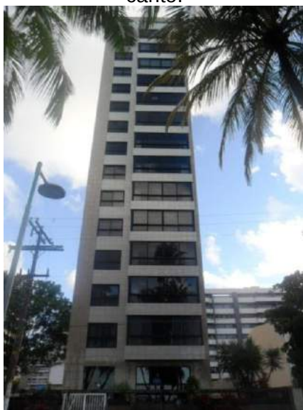
Fig.3.80- Edf. Versalhes, varandas de canto.
