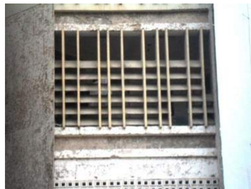
Fig.3.101- Detalhe dos brises, Ed. Solar Graciliano Ramos
