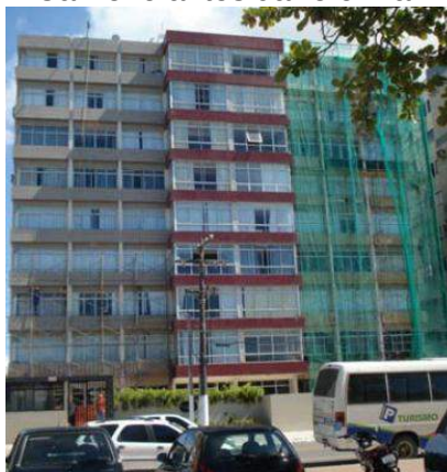
Fig.3.96- Fachada frontal do Edf. Donina Carneiro antes da reforma.
