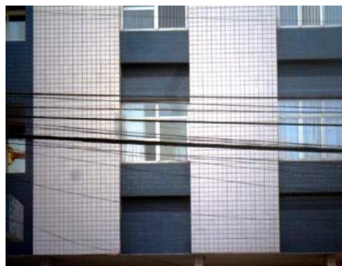
Fig.3.95- Detalhe do peitoril ventilado do Edf. Tatiana.
