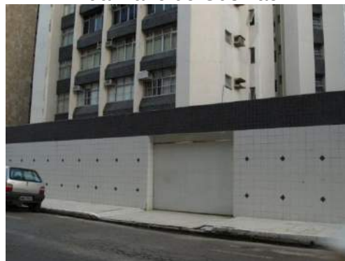
Fig.3.34- Acesso ao edifício Barroca pela Rua Mário de Gusmão.
