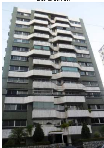
Fig.3.90- Fachada frontal do edifício Porto da Barra.
