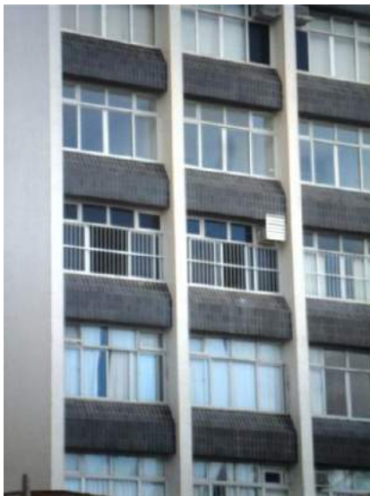
Fig.3.93- Detalhe do peitoril inclinado.
