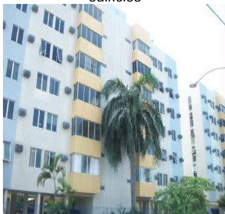
Fig.3.3- Edifício Armando Lobo constituído por três blocos de edifícios
