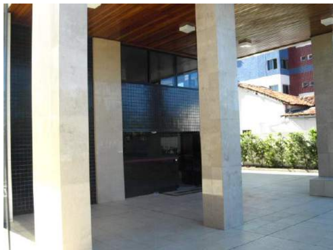
Fig.3.119- Base com dois pavimentos dos edf. Lennie Nichols.
