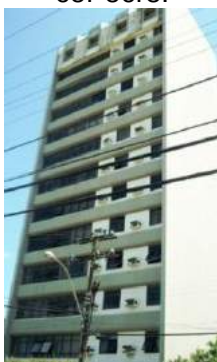
Fig.3.127- Fachada frontal do Edf. Lagoa Mar, revestida em concreto na cor ocre.
