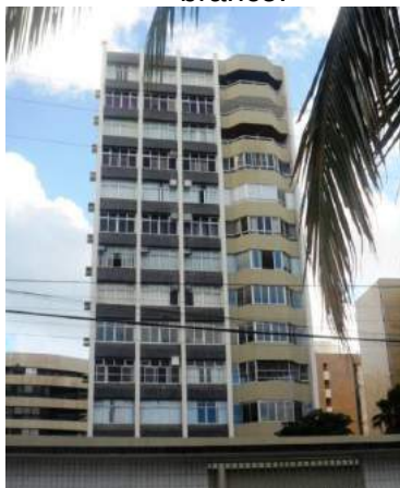
Fig.3.129- Fachada frontal do Edf. Barroca, revestida em concreto na cor ocre, cerâmica na cor preta e pintura na cor branco.
