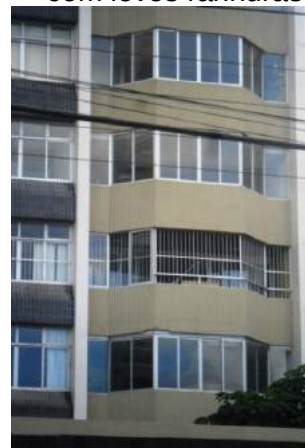
Fig.3.131- Detalhe das varandas do Edf. Barroca, revestida em concreto na cor ocre, com leves ranhuras.
