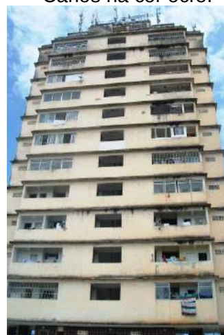
Fig.3.122- Fachada posterior do Edf. São Carlos na cor ocre.
