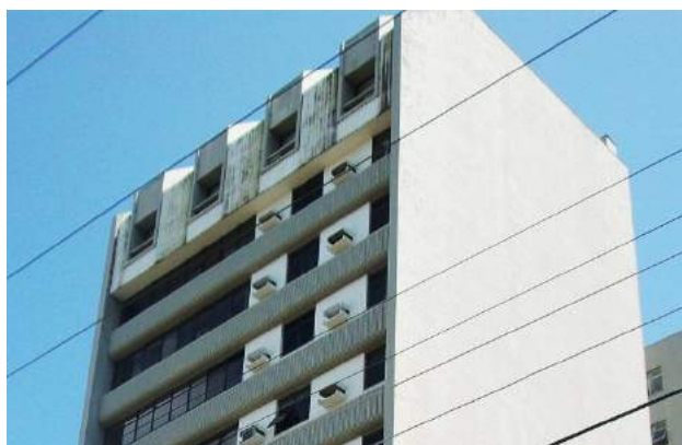
Fig.3.115- Coroamento do edf. Lagoa Mar.
