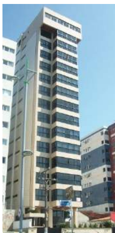
Fig.3.118- Edf. Lannie Nichols com base, corpo e coroamento.
