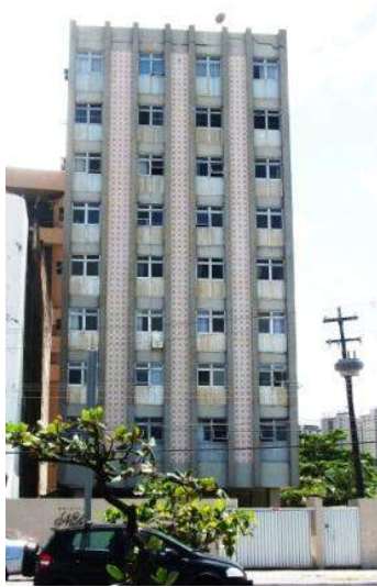
Fig.3.132- Fachada frontal do Edf. Núbia.
