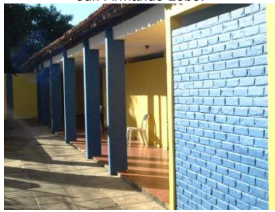
Fig.3.161- Apoio com salão de festas no edf. Armando Lobo.
