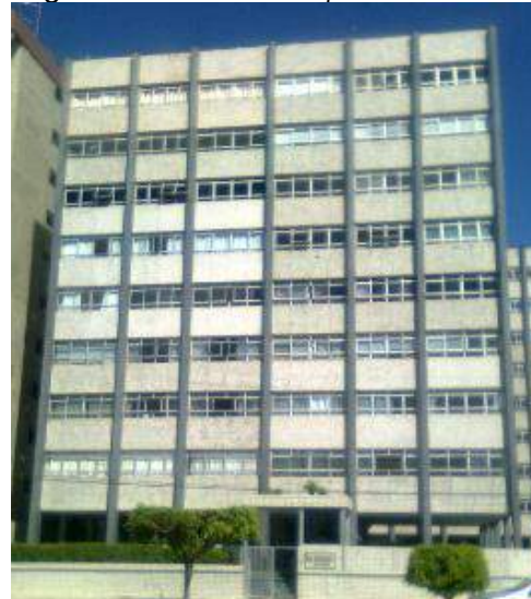
Fig.3.89- Fachada frontal dos Edf. Jangada com demarcações horizontais.
