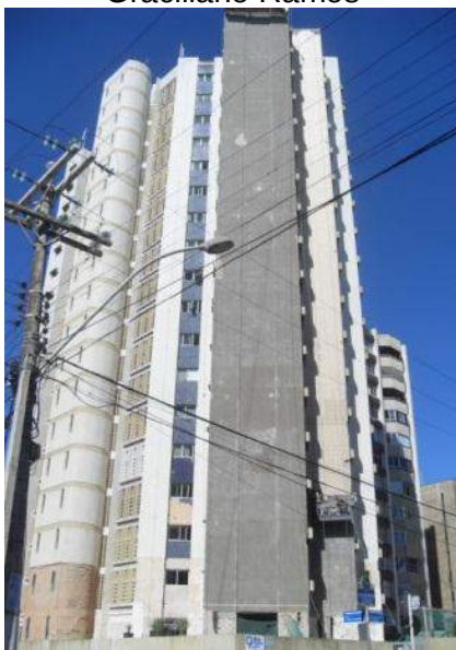
Fig.3.74- Fachada lateral do Edf. Solar Graciliano Ramos
