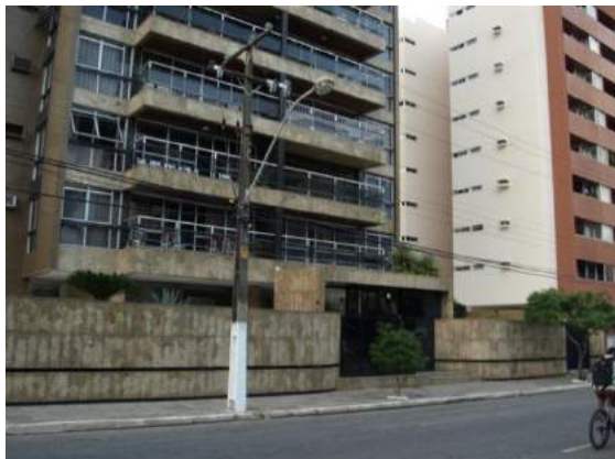
Fig.3.39- Acesso ao edf. Biarritz pela Rua Mário de Gusmão.
