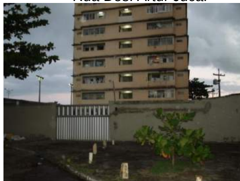
Fig.3.24- Acesso ao edf. São Carlos pela Rua Des. Artur Jucá.
