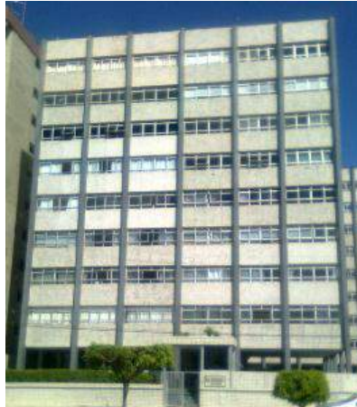
Fig.3.107- Edifício Jangada (1970), base e corpo.
