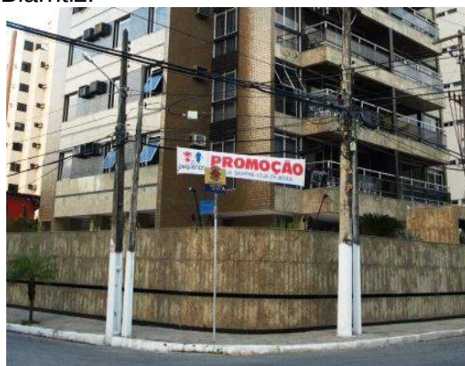
Fig.3.48- Presença de muro no edifício Biarritz.
