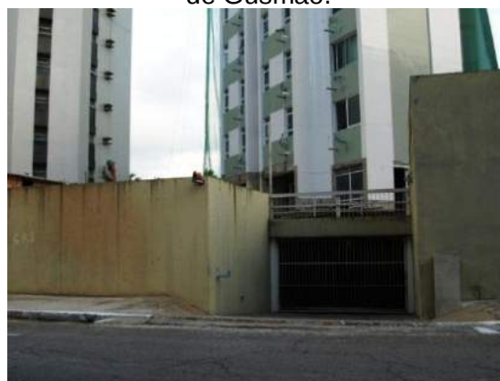
Fig.3.42- Acesso ao subsolo do edifício Solar Graciliano Ramos pela Rua Mário de Gusmão.
