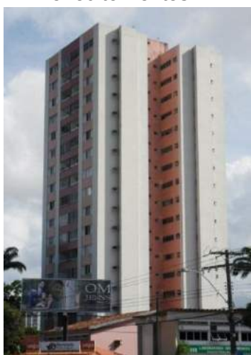
Fig.3.102- Varanda confinada no Edf. Benedito Bentes.
