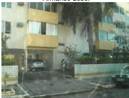
Fig.3.4- Detalhe do bloco de edifício do edifício Armando Lobo.
