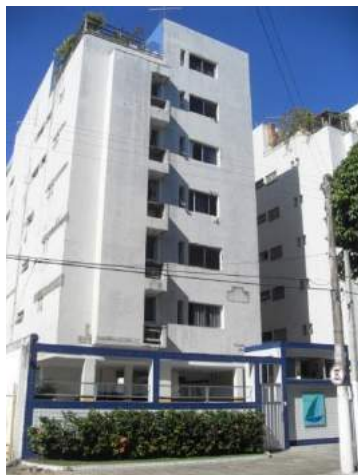
Fig.3.135- Fachada frontal do Edf. Veleiro.
