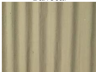
Fig.3.130- Revestimento em concreto utilizado na varanda do edf. Barroca.
