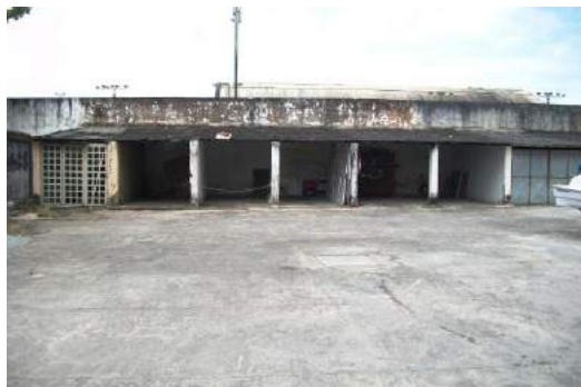
Fig.3.15- Garagem do edifício São Carlos.
