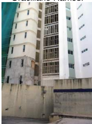
Fig.3.100- Fachada lateral do Edf. Solar Graciliano Ramos.
