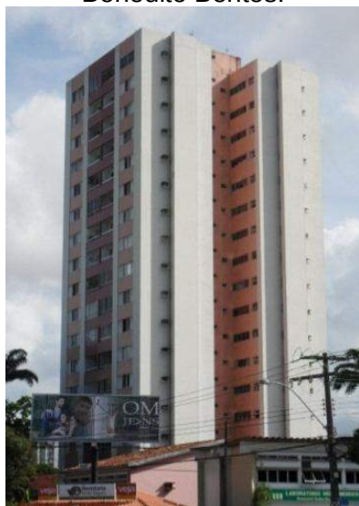
Fig.3.71- Fachada lateral do Edf. Benedito Bentes.
