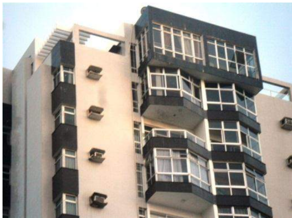
Fig.3.126- Detalhe da fachada do Edf. Praia Verde, cores branco e preto.
