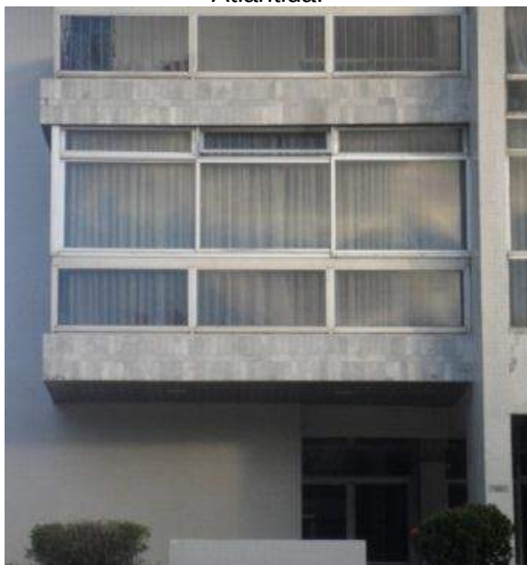
Fig.3.104- Varanda em balanço, Edf. Atlântida.
