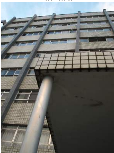
Fig.3.84- Edf. Jangada, pilares compõe a fachada.
