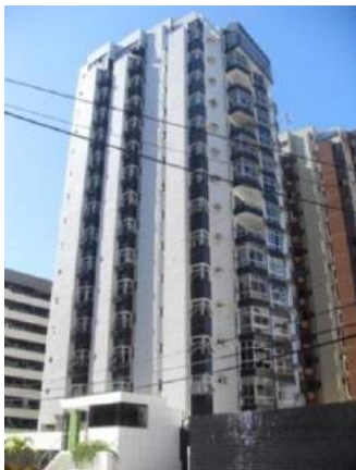
Fig.3.76- Edf. Praia Verde, varandas na fachada lateral.
