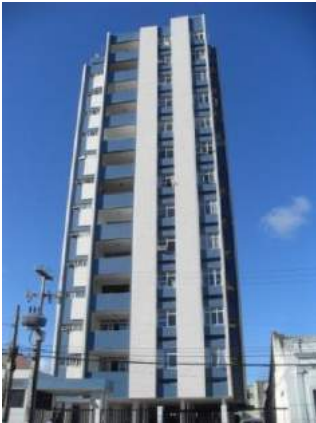
Fig.3.109- Edifício Tatiana (1975), base e corpo.
