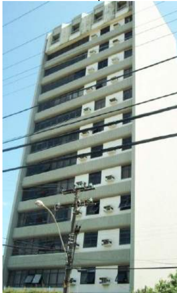
Fig.3.88- Fachada frontal dos Edf. Lagoa Mar com demarcações horizontais.
