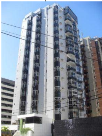
Fig.3.125- Fachada frontal do Edf. Praia Verde, bicromatismos nas cores branco e preto.
