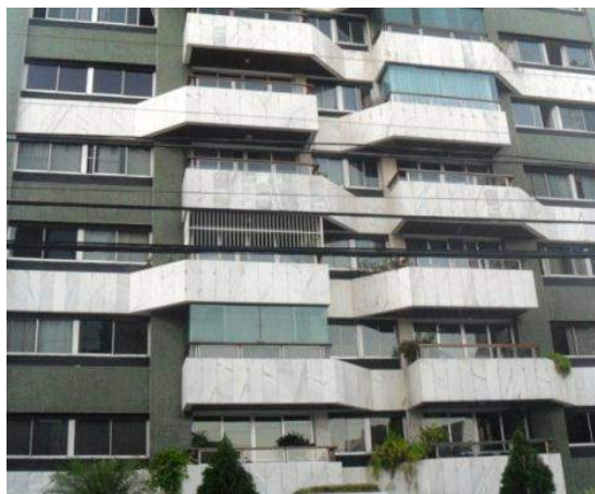
Fig.3.134- Detalhe das varandas do Edf. Porto da Barra.
