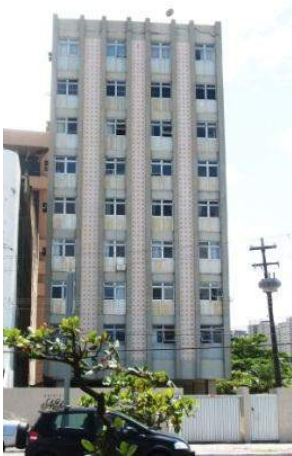
Fig.3.106- Edifício Núbia (1970), base e corpo.
