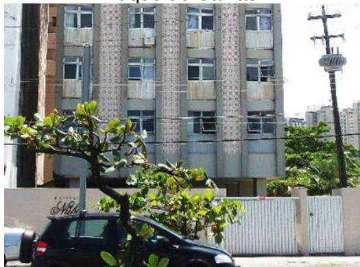
Fig.3.25- Acesso ao edf. Núbia pela Av. Duque de Caxias.
