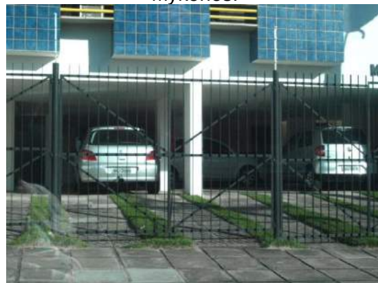
Fig.3.20- Garagem no pilotis do edf. Mykonos.
