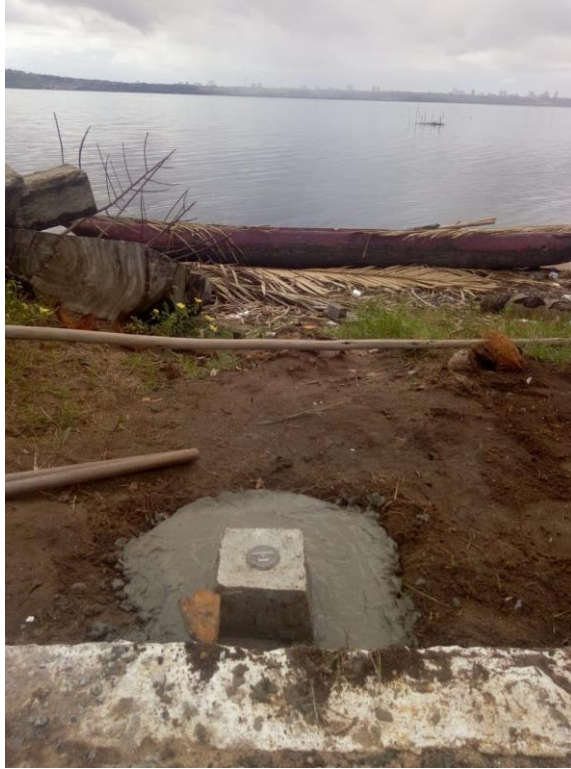
Figura 27 – Preenchimento do restante da cava com a massa da fundação
