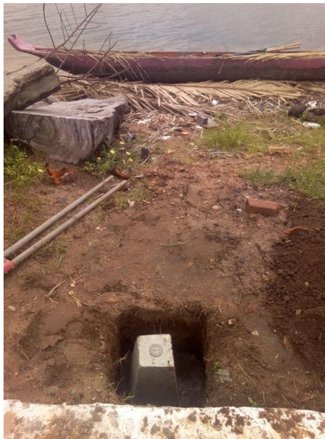
Figura 26 – Assentamento do marco no local para materialização da estação-base – 2018
