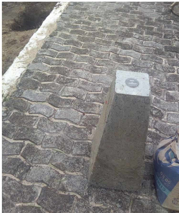
Figura 23 – Perfil do marco piramidal padrão IBGE – 2018
