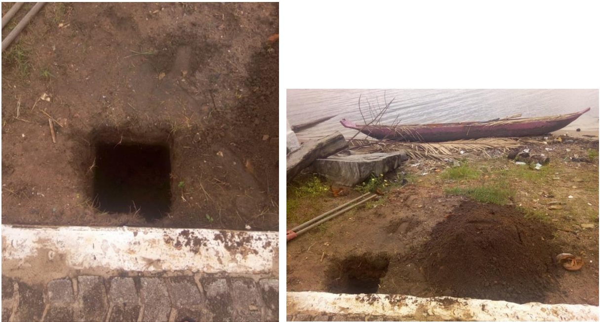
Figuras 24 e 25 – Local para materialização da estação-base através do marco topográfico – 2018
