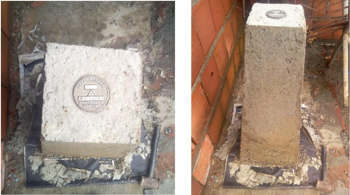
Figura 21 e 22 – Confeção do marco piramidal padrão IBGE – 2018
