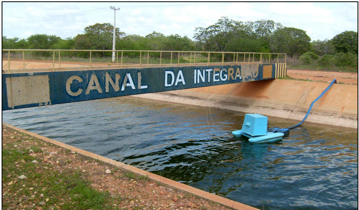
Figura 17 – Trecho do Canal da Integração com bomba flutuante
