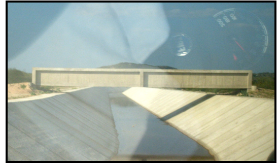
(b) Travessia concluída
