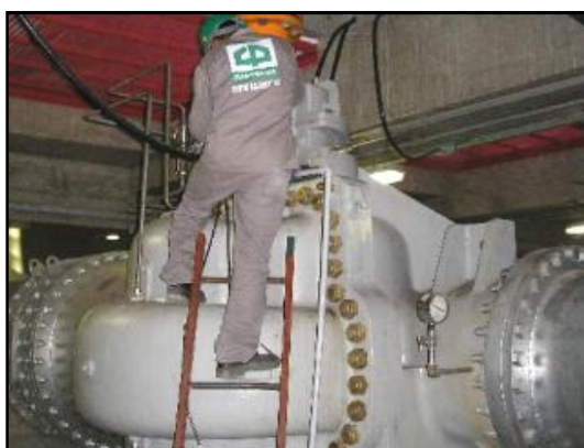
Figura 19 – Motores e bombas da estação elevatória do Canal da Integração
