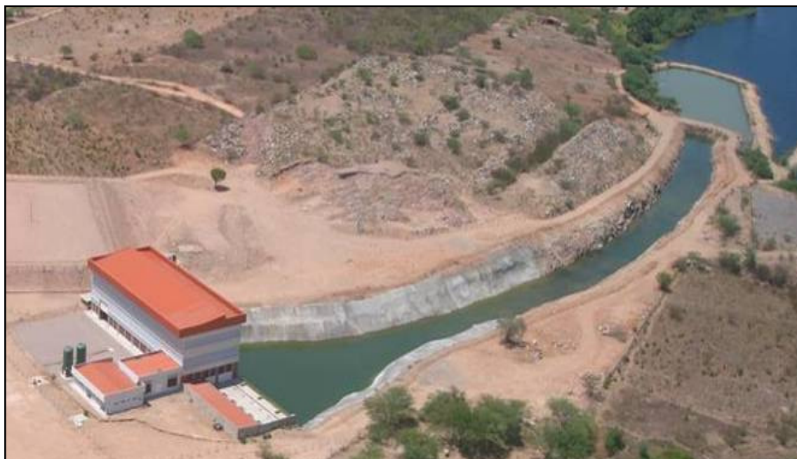
Figura 30 – Ensecadeira, canal de aproximação e estação elevatória do Canal do Sertão
