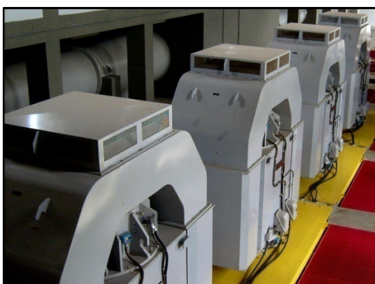
Figura 19 – Motores e bombas da estação elevatória do Canal da Integração
