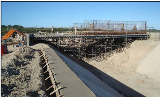
(a) Travessia em construção
