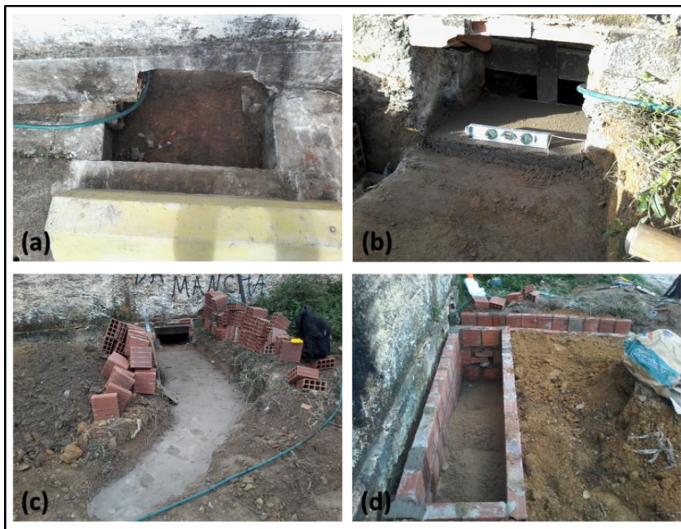
Figura 14 – Execução da infraestrutura do amostrador
