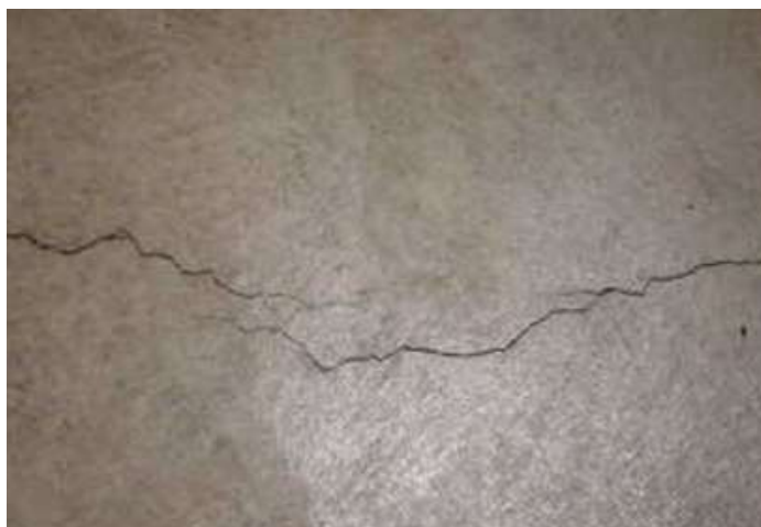
Figura 17 - Fissuras em uma laje.
