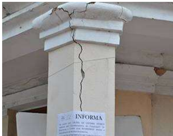
Figura 19 - Pilar com trinca vertical devido ao excesso de carga.
