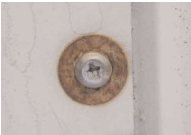
Figura 9 - Corrosão de uma arruela banhada em cádmio em contato com um parafuso de aço inoxidável.
