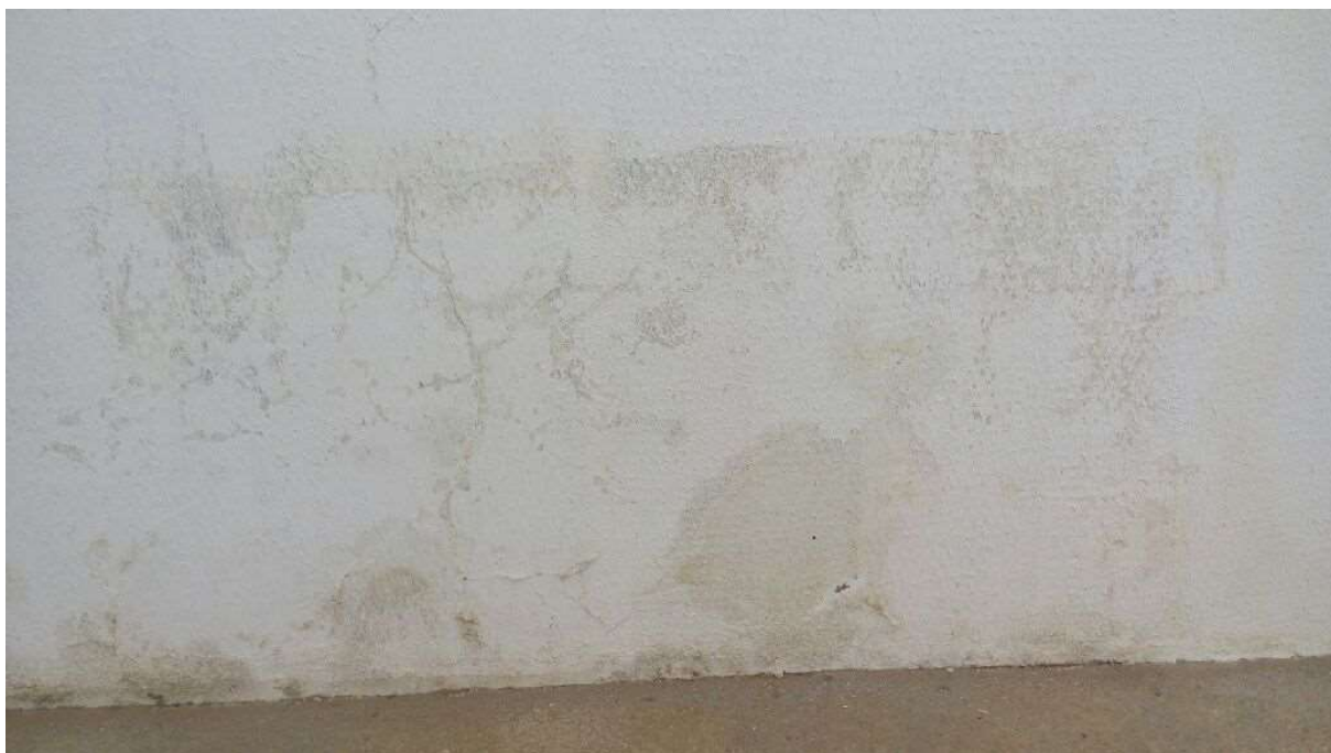
Figura 32 - Manchas na parede externa do muro.
