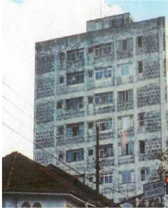
Figura 21- Manchas ocasionadas por microrganismos.
