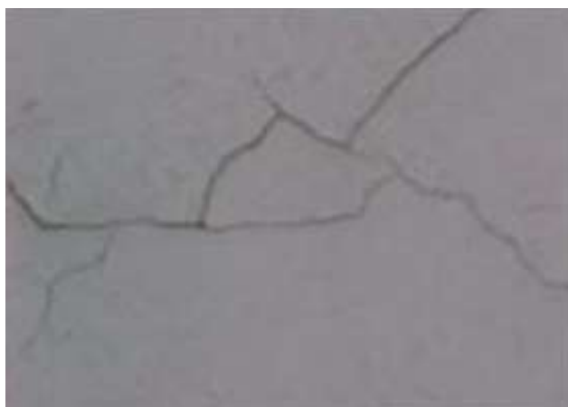
Figura 13 - Exemplo de fissura.
