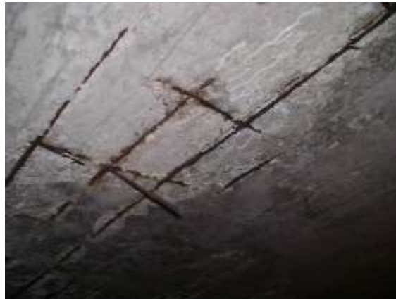
Figura 24 - Corrosão nas armaduras de uma laje.
