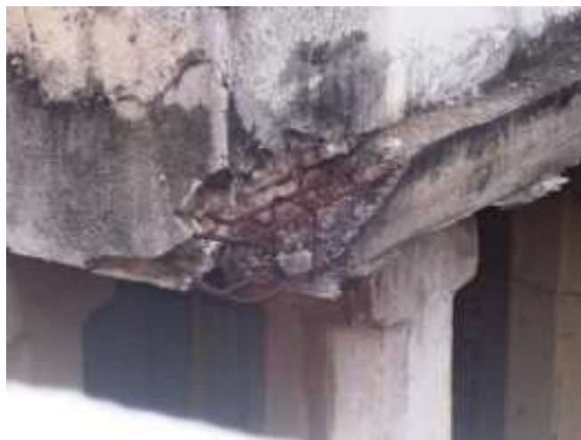
Figura 22 - Desagregação de concreto em viga e exposição da armadura.
