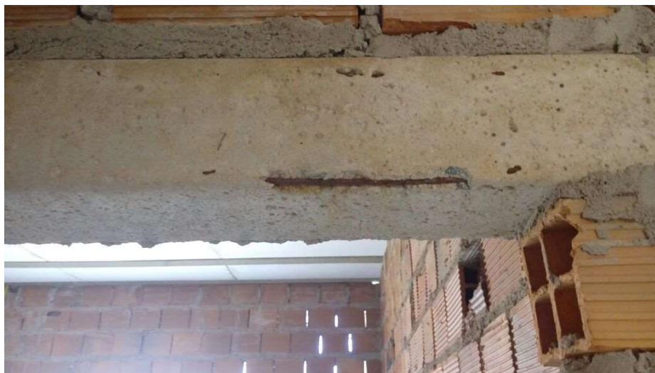
Figura 30 - Corrosão da amadura de uma contraverga.
