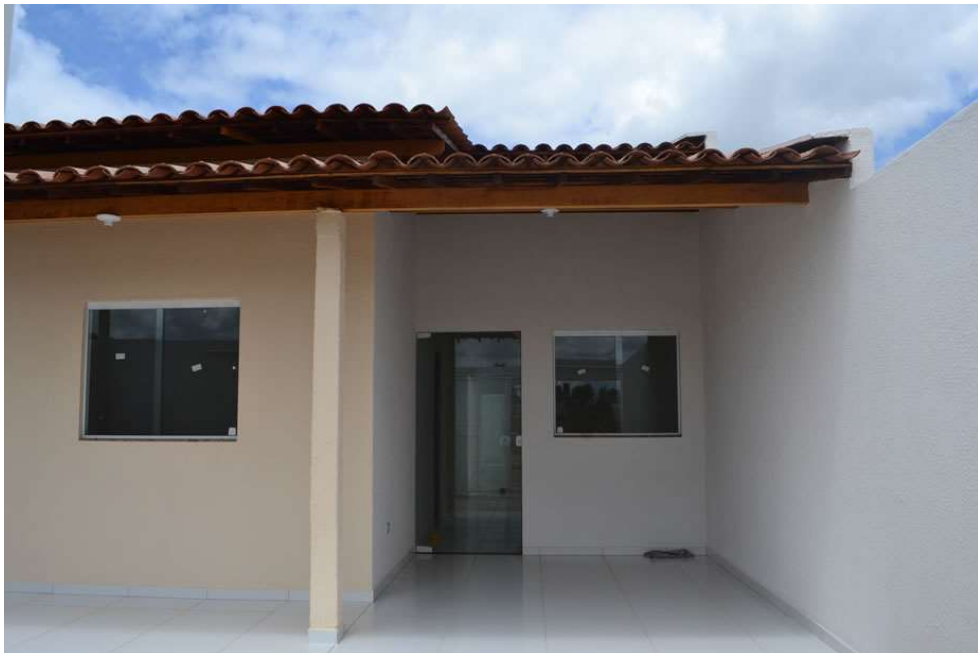
Figura 27- Garagem e Varanda.
