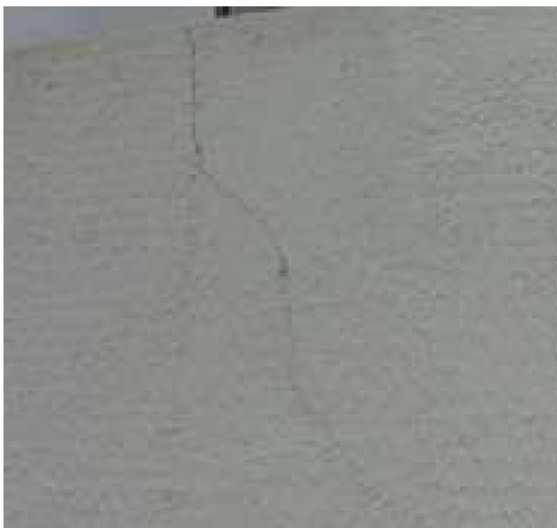
Figura 29 - Fissuras em muro.
