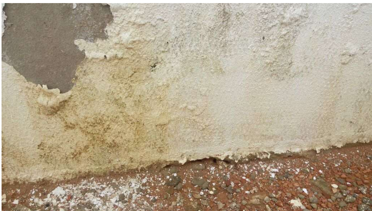
Figura 33 - Descascamento na parede interna do muro.
