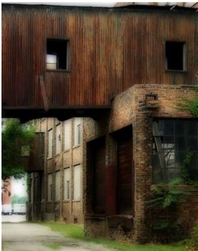
Figura 6 - Corrosão devido a agentes atmosféricos.
