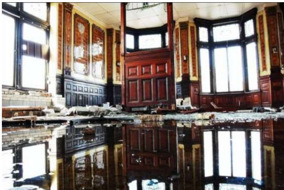
Figura 8 - Acúmulo de Água.
