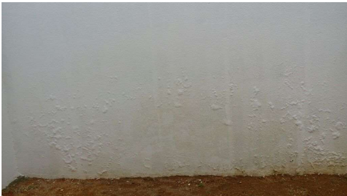
Figura 31- Bolhas na parede interna do muro.
