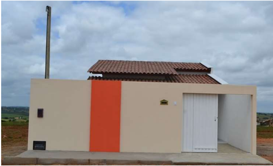
Figura 26 - Fachada da residência e poste elétrico.
