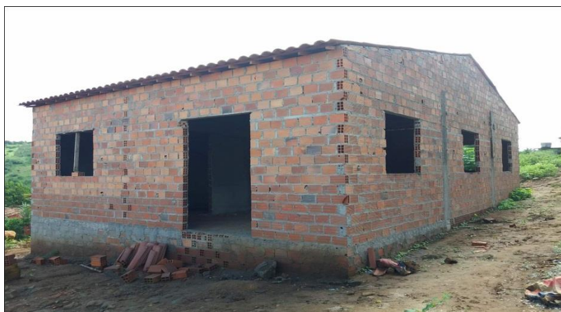
Figura 11: Construção do centro cultural.
