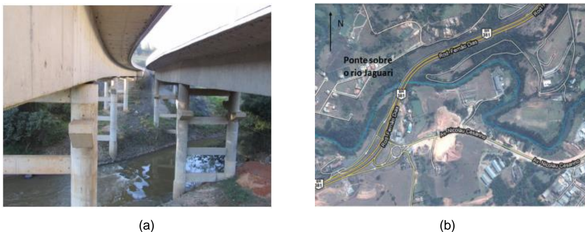
Figura 5.8 – Pontes sobre o Rio Jaguari: (a) vista geral; (b) localização
