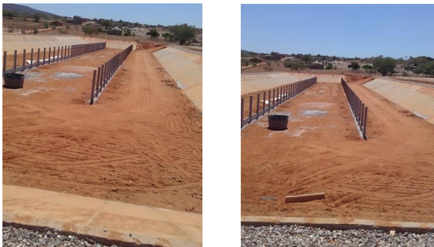
Figuras 7 e 8 – Construção das lagoas de tratamento
