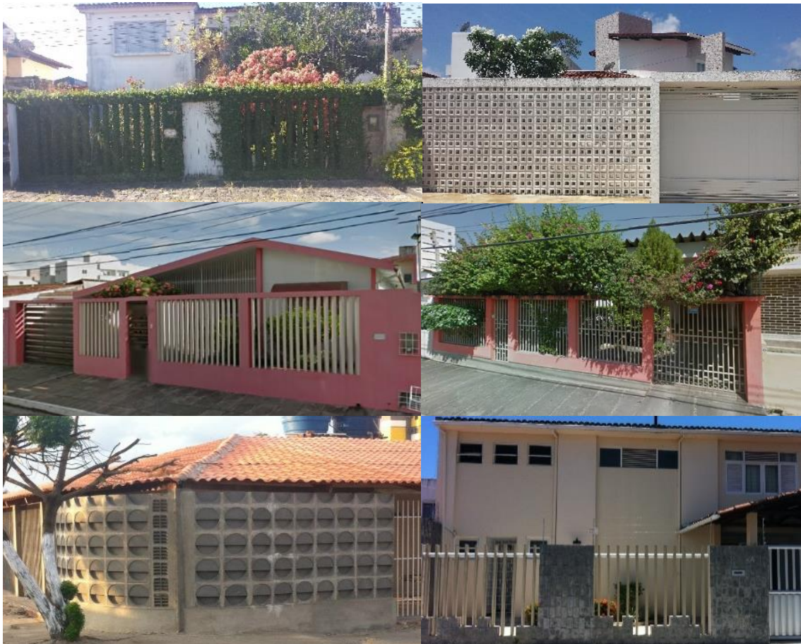
Figura 32 – Exemplos de edificações residenciais localizadas em Maceió/AL com muros constituídos por diferentes elementos vazados
