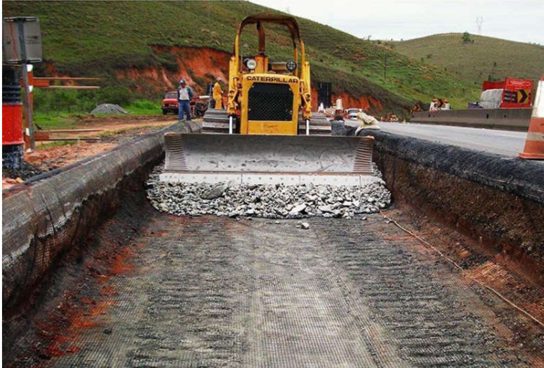
Figura 7 – Aplicação de geogrelha como reforço de camada de base. Fonte: Huesker (s. d.).
