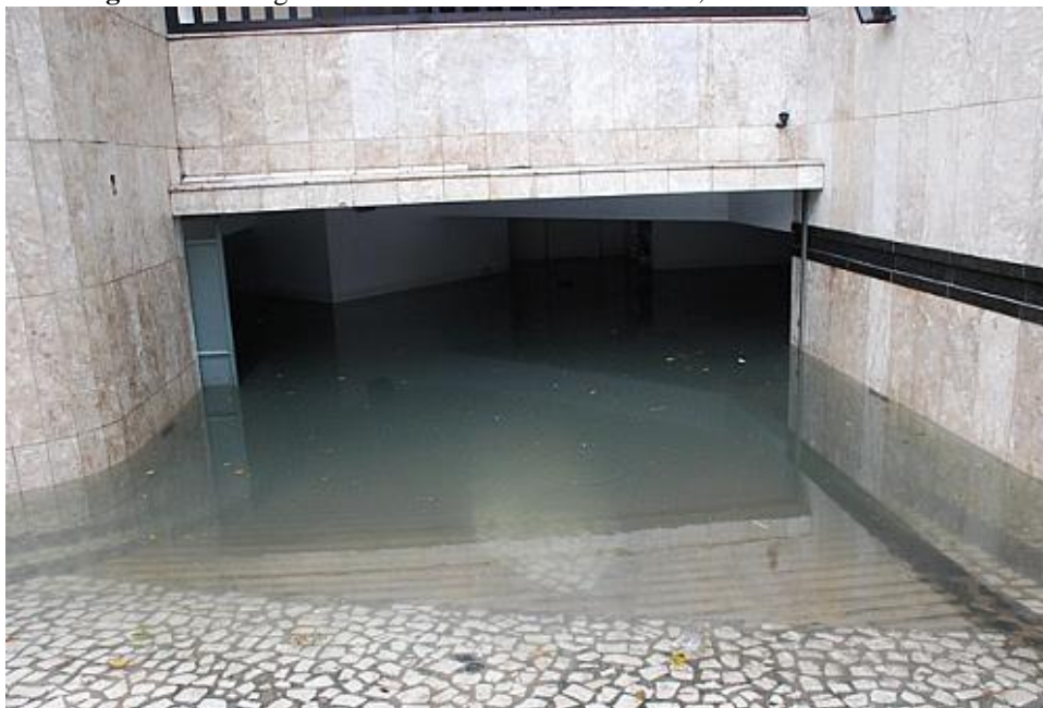
Figura 26: Garagem do Edifício Don Ponce de Leon, bairro da Ponta Verde.
