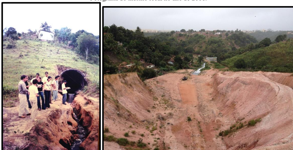
Figura 4: (à esq.) Fotografia da saída da macrodrenagem do tabuleiro em 2004, após sua inauguração. (à dir.) Fotografia do mesmo local no ano de 2016.
