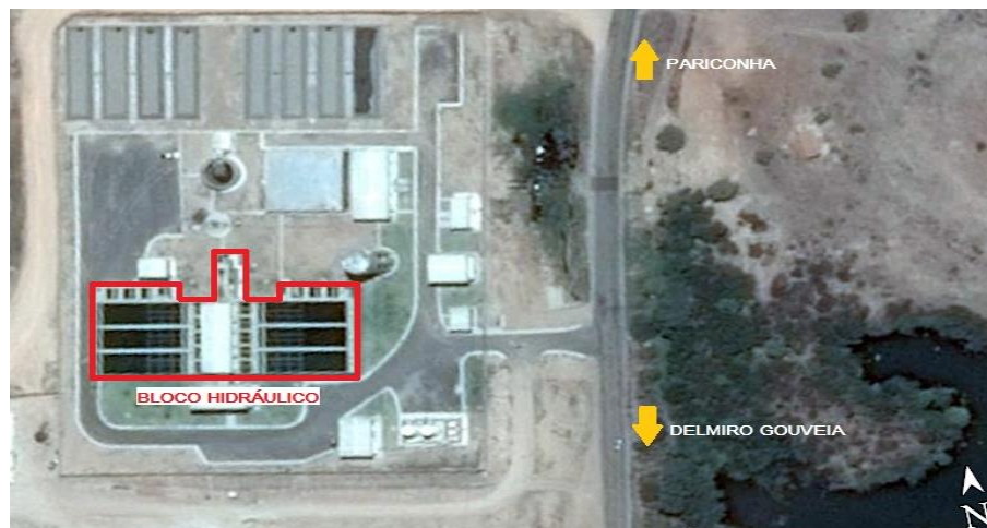
Figura 14 - Imagem de satélite do bloco hidráulica da ETA do município de Pariconha.
