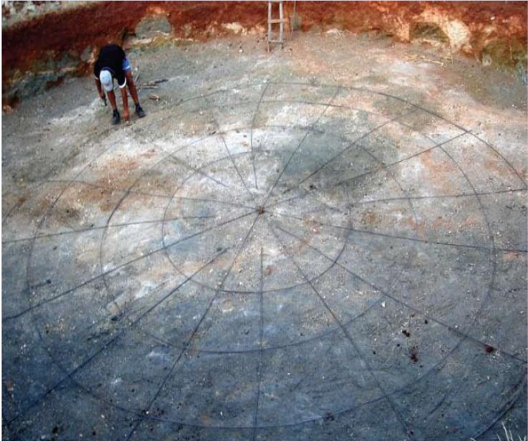
Figura 10: Armação da laje do fundo do reservatório. Fonte: Diaconia
