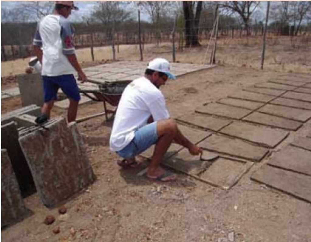
Figura 8: Confeção das placas para o teto da cisterna. Fonte: Diaconia
