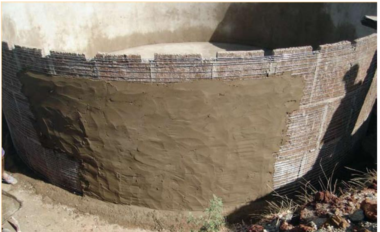
Figura 13: Reboco da parte externa. Fonte: Programa Cisternas.
