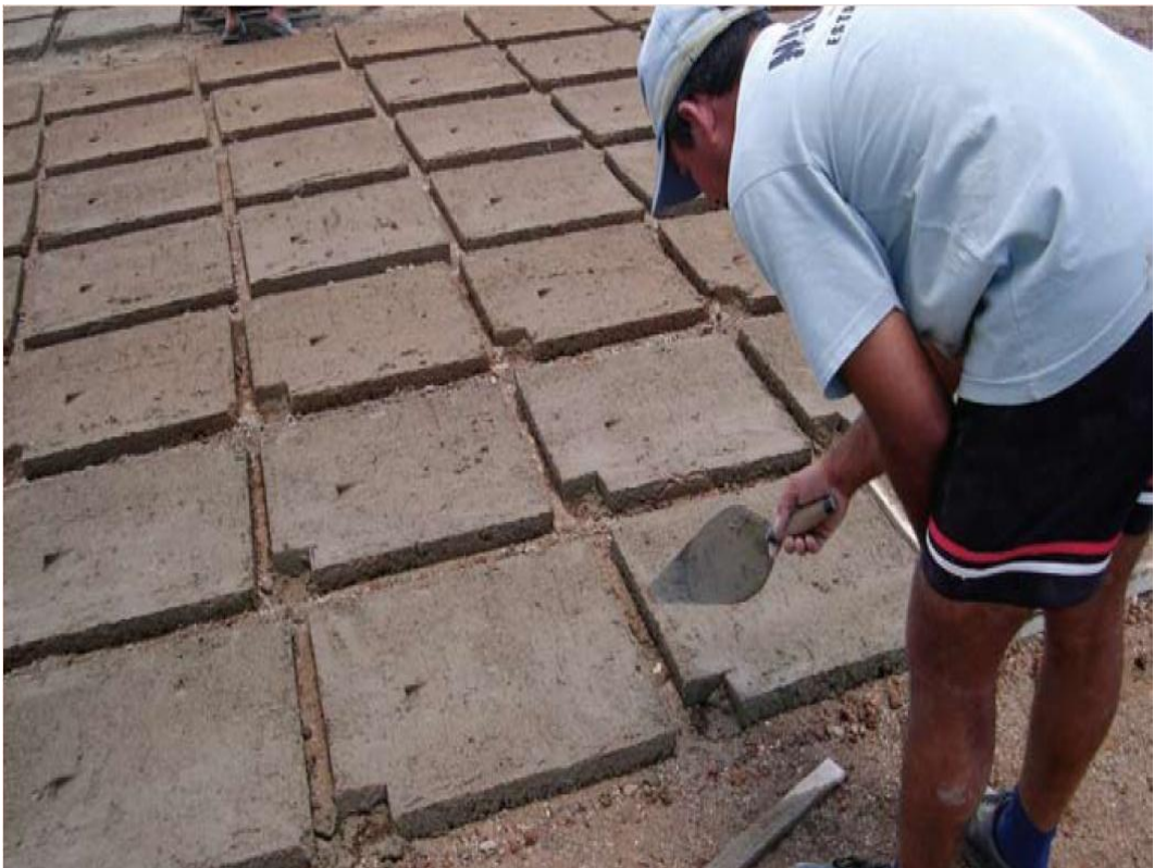
Figura 7: Confecção das placas para paredes da cisterna. Fonte: Diaconia.
