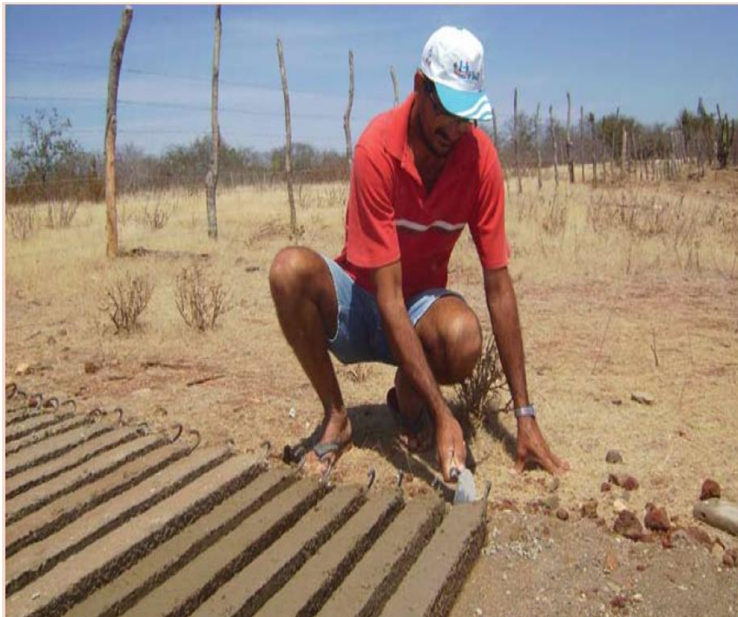
Figura 9: Construção das vigas que sustentarão a tampa da cisterna. Fonte: Diaconia.
