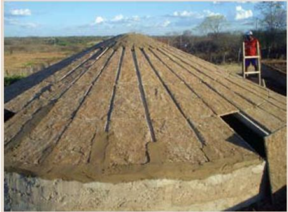
Figura 16: Colocação das placas para o teto do reservatório. Fonte: Diaconia
