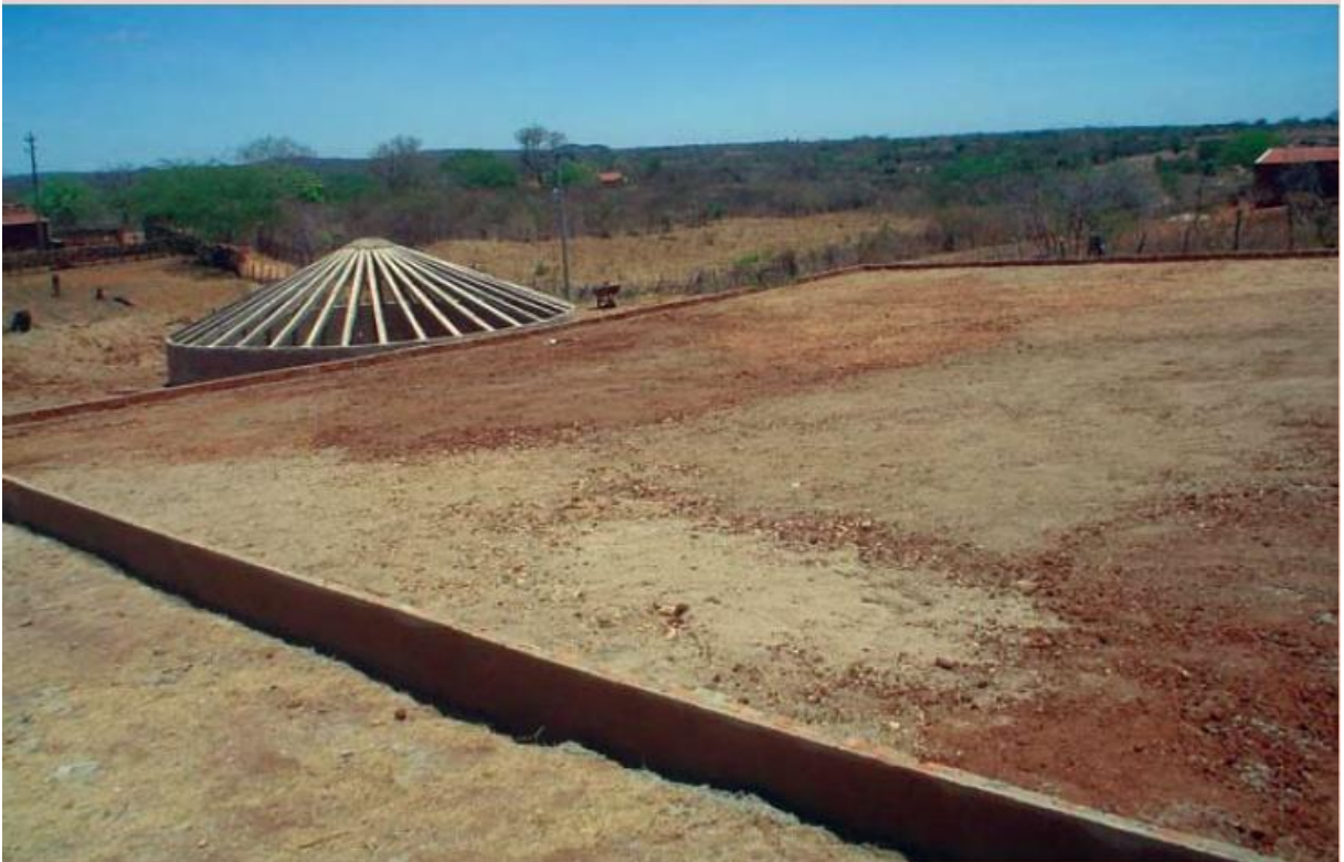
Figura 18: Construção do muro do calçadão de captação. Fonte: Diaconia.
