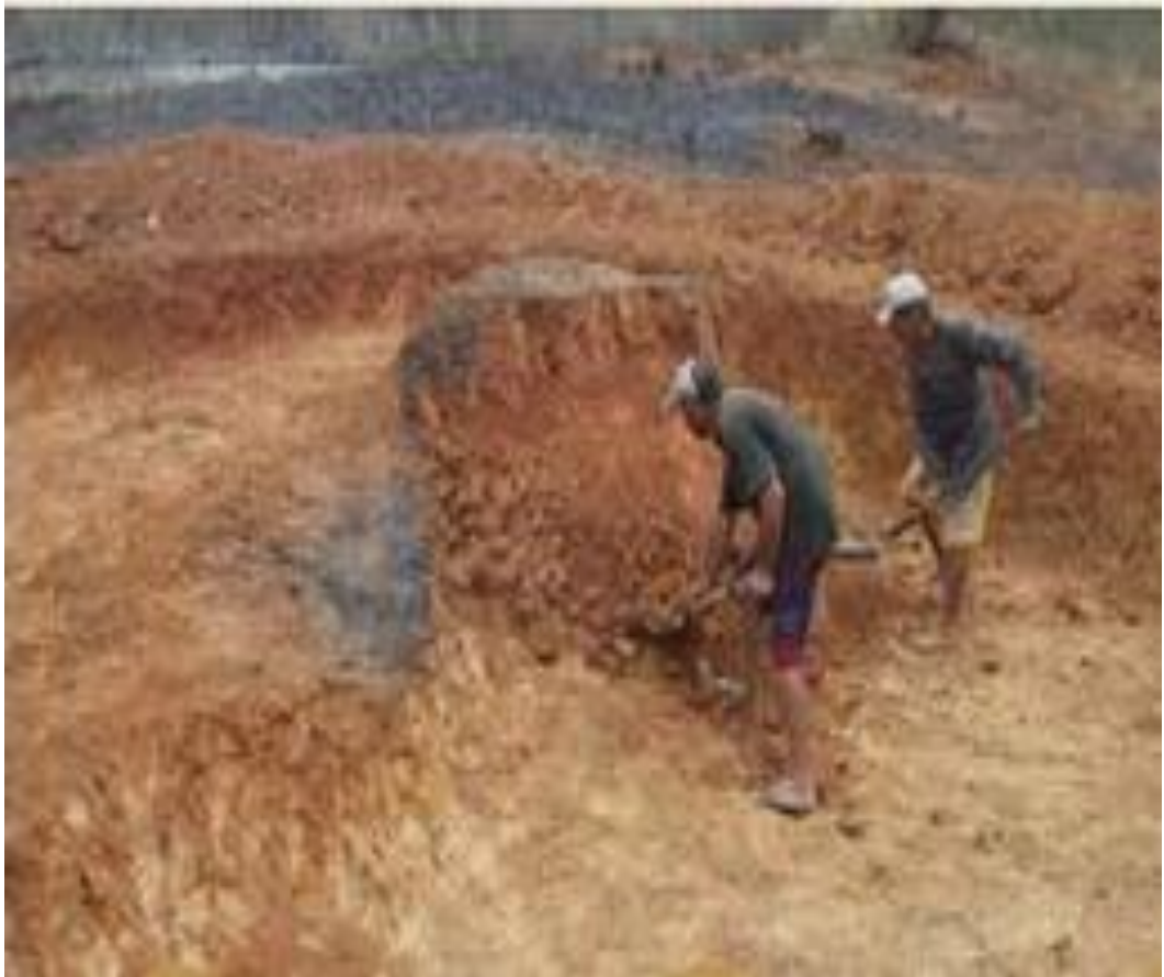
Figura 6: Escavação para construção do reservatório. Fonte: ASA.
