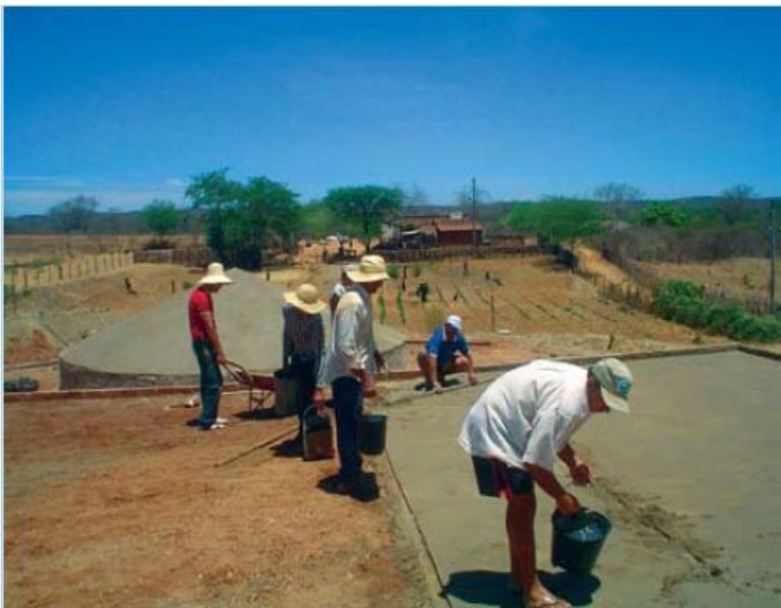
Figura 19: Construção do piso cimentado do calçadão. Fonte: Diaconia.
