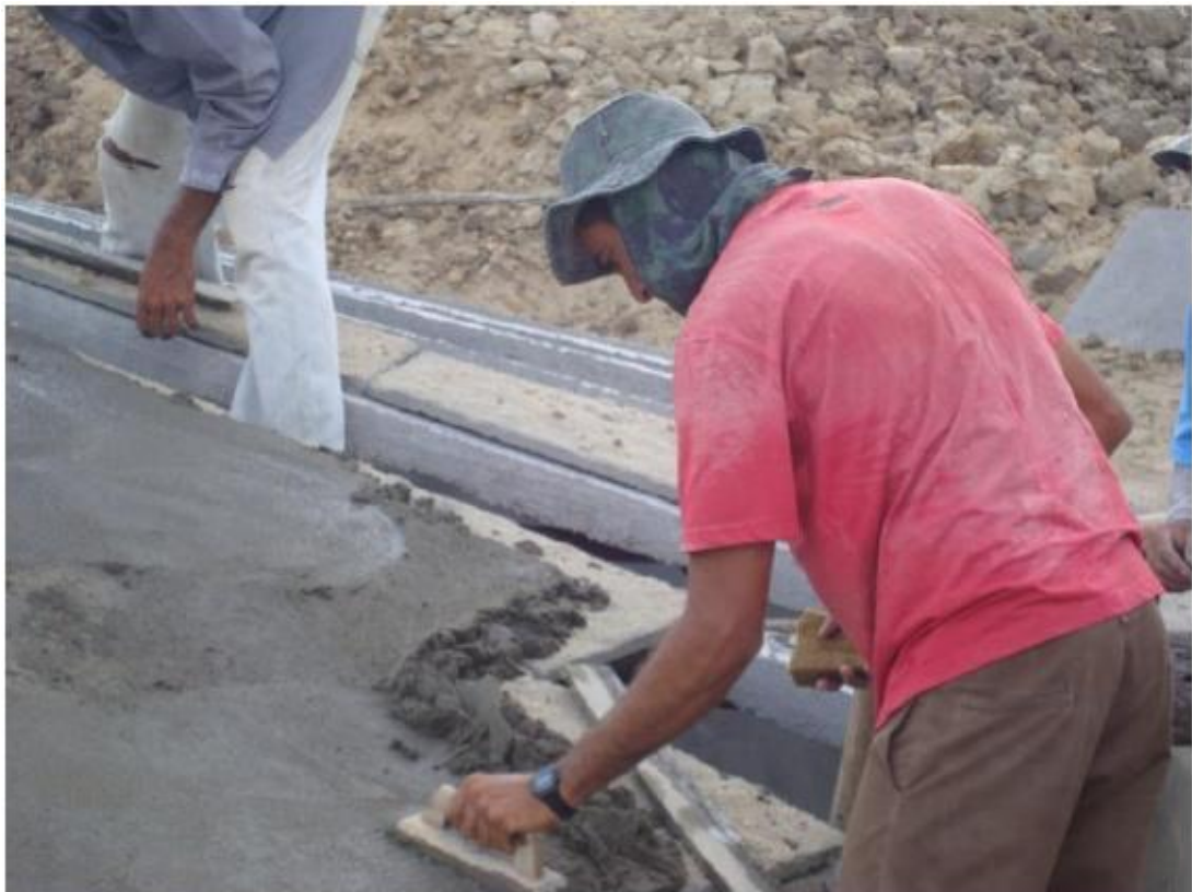
Figura 17: Reboco do teto da cisterna. Fonte: Programa Cisternas
