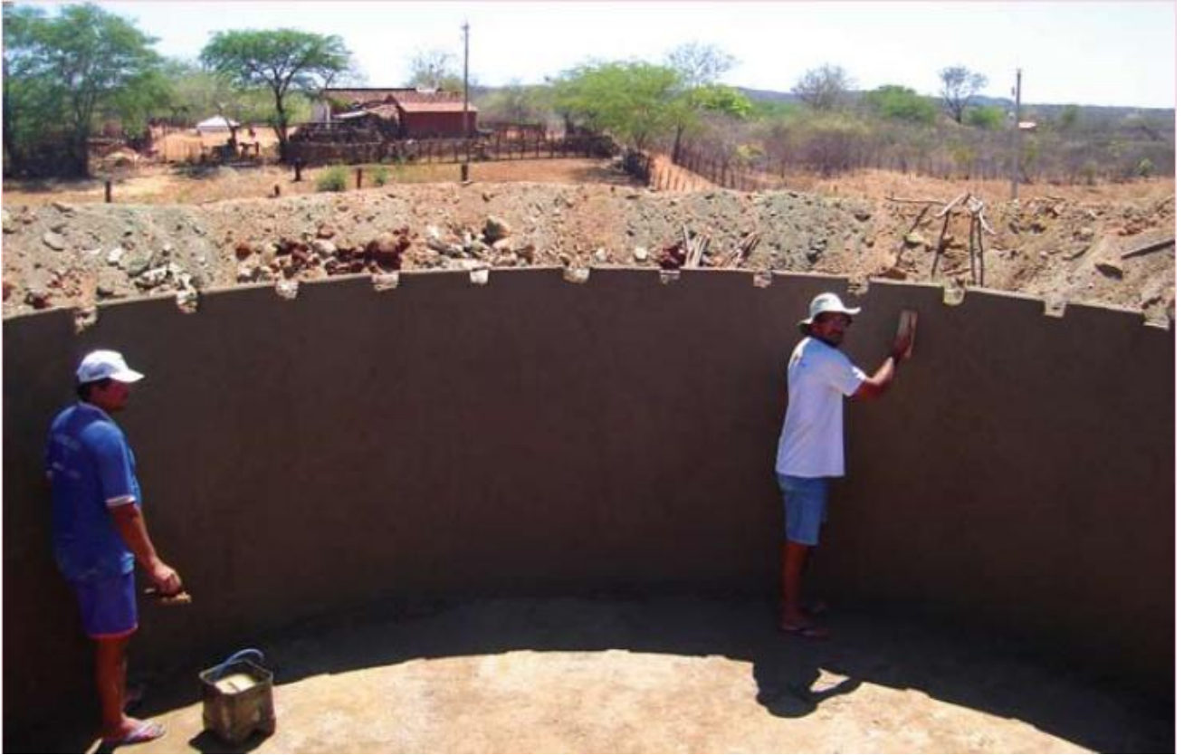
Figura 14: Execução de reboco da parte interna. Fonte: Diaconia.
