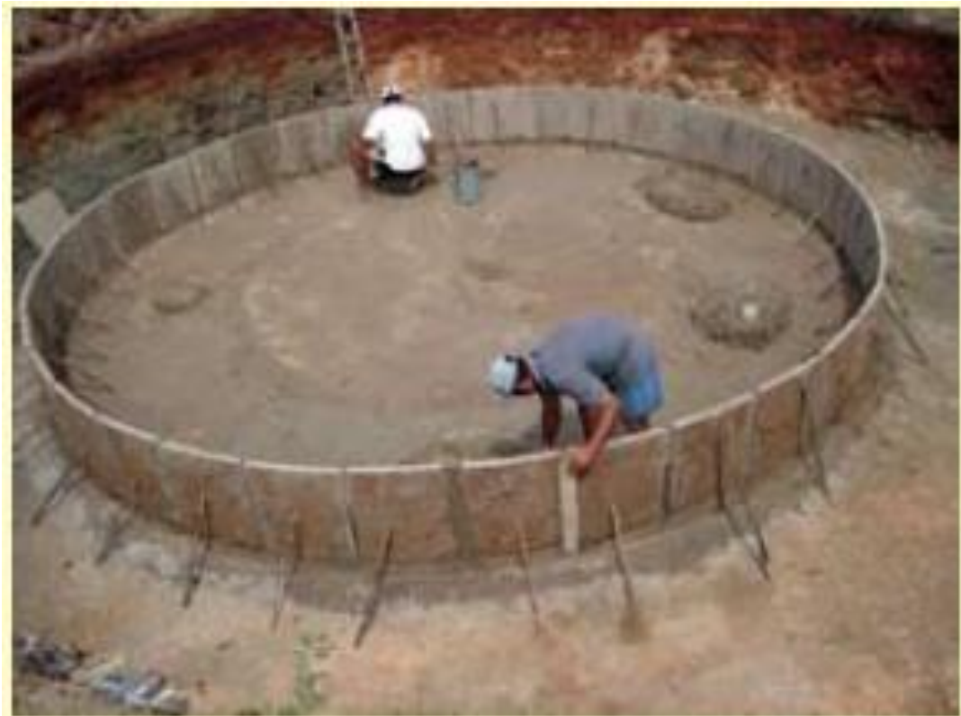
Figura 11: Levantamento das placas da parede da cisterna. Fonte: Diaconia.
