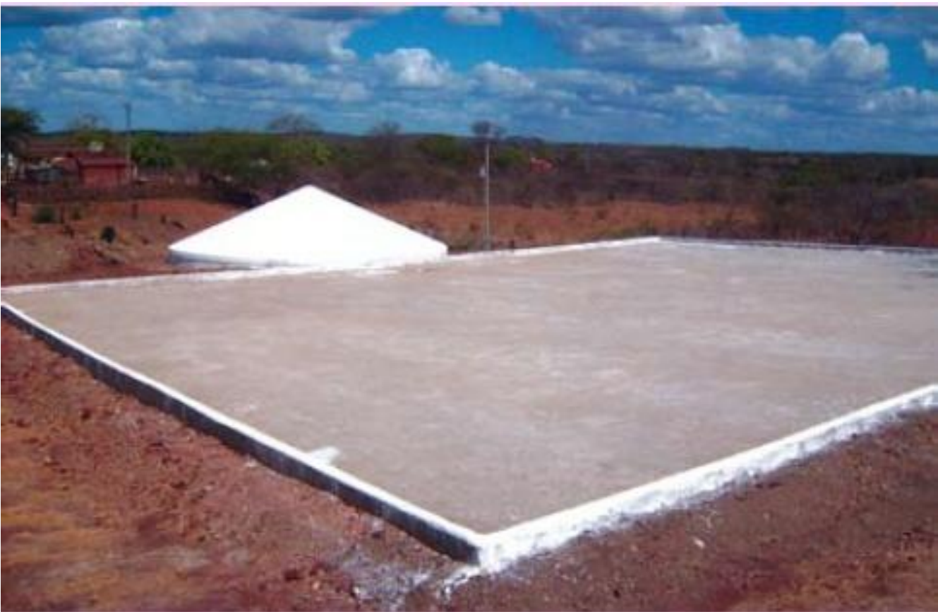
Figura 21: Cisterna Tipo Calçada finalizada. Fonte: Diaconia.
