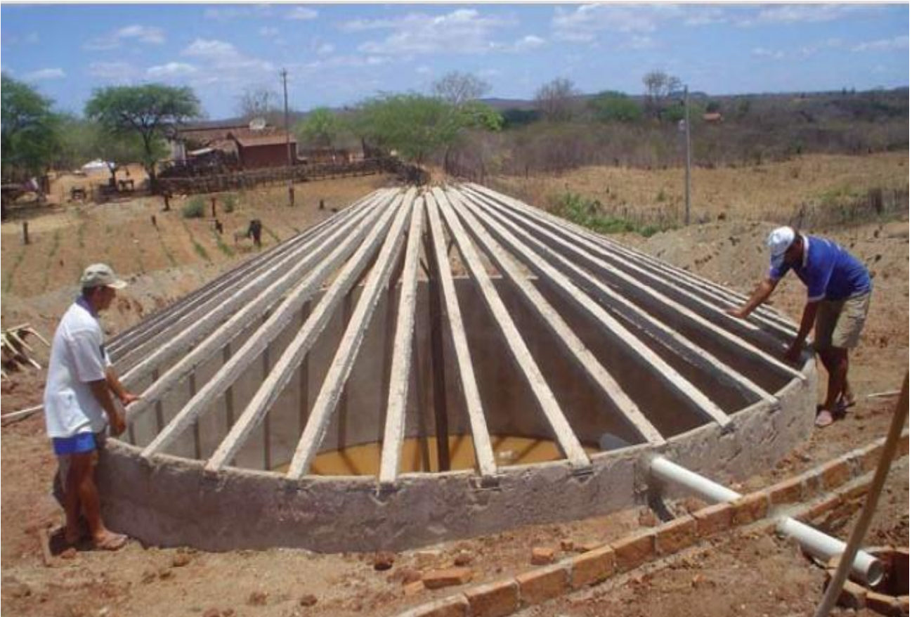
Figura 15: Colocação das vigas para o teto do reservatório. Fonte: Diaconia.
