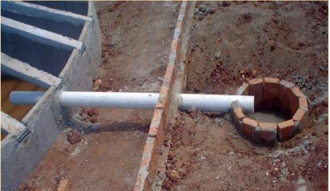
Figura 20: Construção do decantador. Fonte: Diaconia.
