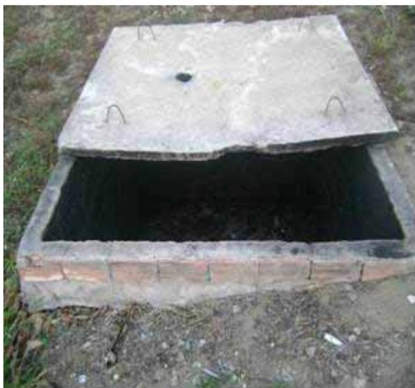
**Figura 28 - Tanque (queimador) construído para receber RSS de Ibateguara.**
