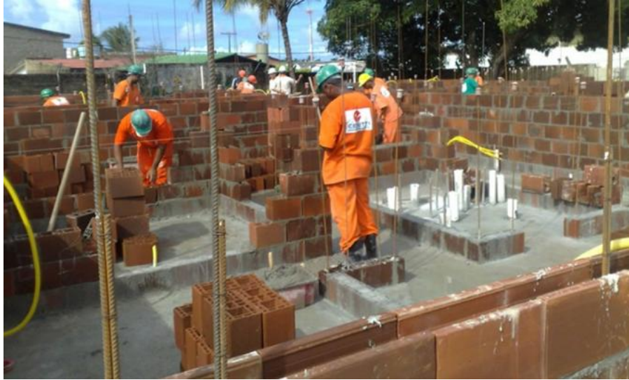
Figura 1.1 – Fotografia durante a fase de construção do condomínio Eco Villares II, em Maceió-AL - FONTE: http://cerutti.tmp.2i9.com.br/pt/obras . Acessado em outubro de 2010.
