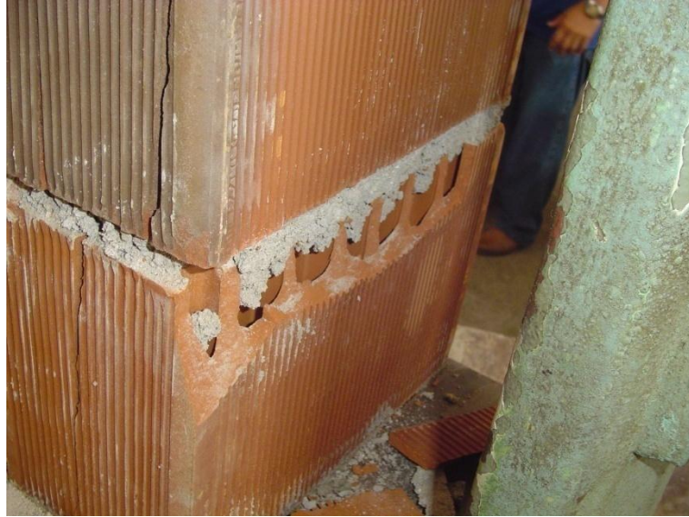
Figura 3.24 - Exemplo de um prisma 150.20 após ruptura.
