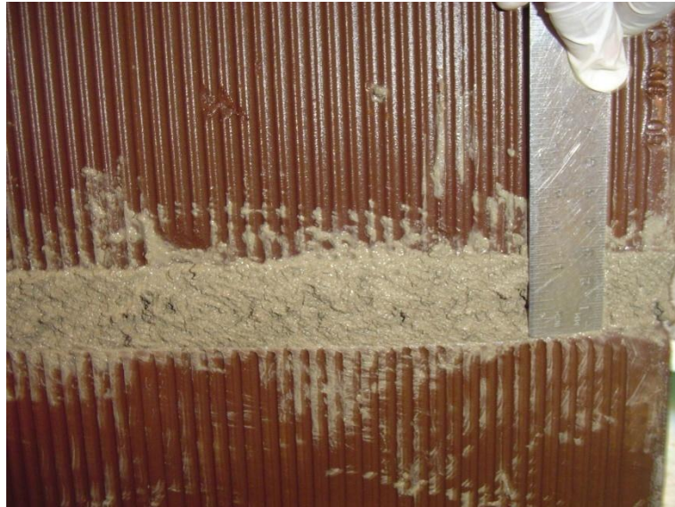
Figura 3.13 - Medição da espessura da junta de assentamento.
