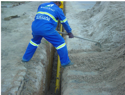
(a) Tubulação para transporte de gás natural (Fonte: Santos Júnior e Vieira, 2006).
