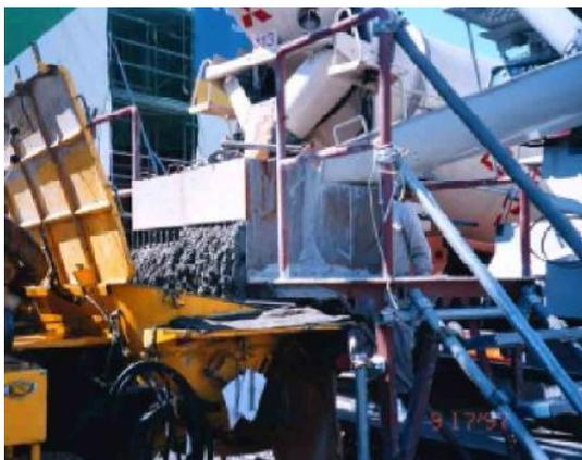
Figura 2.6 – Verificação da auto-adensabilidade do concreto no canteiro de obras
