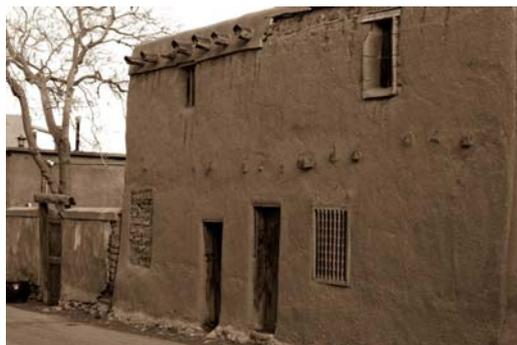
Figura 2.26 – Casa construída no ano de 1540: adobe reforçado com palha
