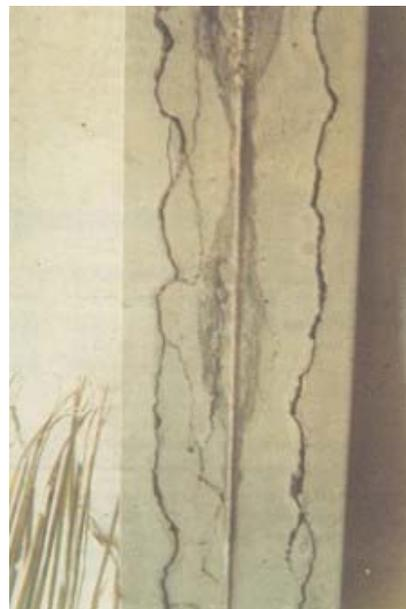
Figura 11: Corrosão em pilar de concreto por ataque de cloretos.
