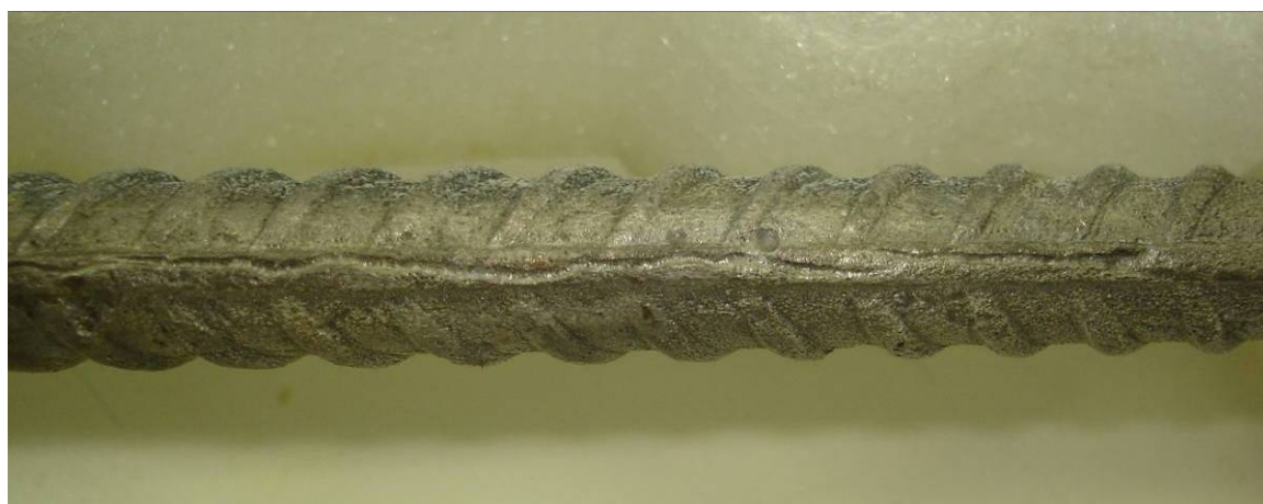
Figura 5.43 – Cavidade contínua resultante das reações de corrosão.
