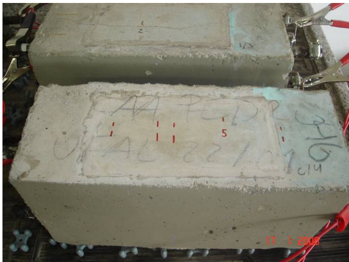
Figura 5.39 – Início da fissuração do CAA-RCMG.
