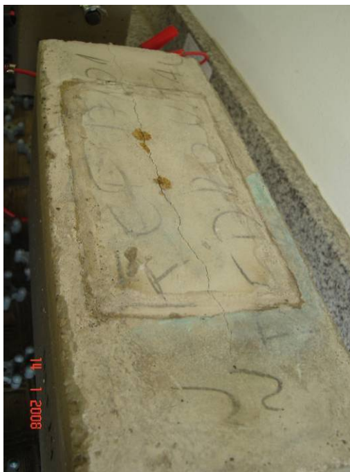
Figura 5.38 – Início da fissuração do C-REF, com afloração de produtos de corrosão.
