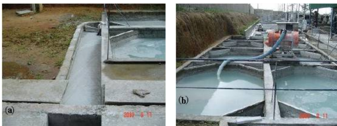
Figura 4.4 – (a) Detalhe da valeta que leva o resíduo aos tanques com água; (b) Material dos tanques sendo bombeado para as lagoas (LISBÔA, 2004).
