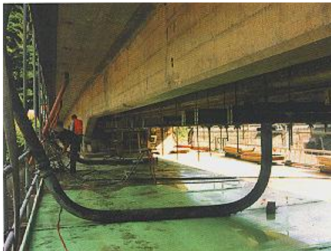
Figura 04 – Recuperação de uma ponte, na Suíça.
