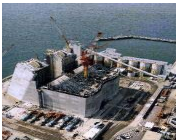
Figura 02 – Bloco de ancoragem da ponte Akashi Kaikyo, no Japão.
