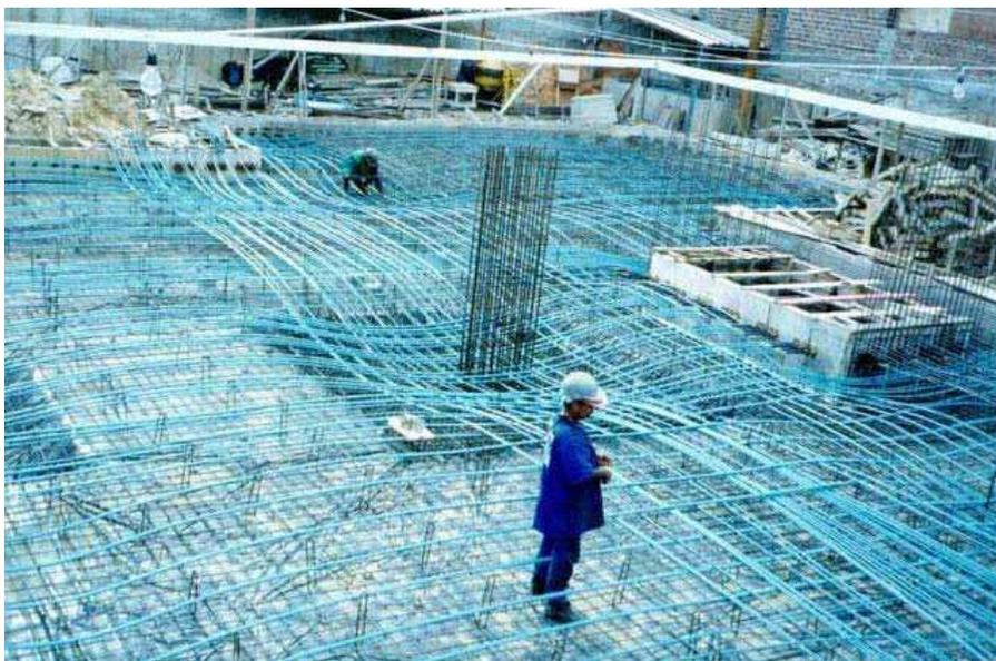
Figura 2.9 – Radier em concreto protendido.
