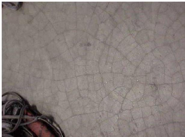
Figura 2.6 – Fissuras superficiais concentradas.
