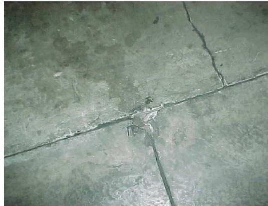
Figura 2.7 – Fissuras de retração por evaporação.
