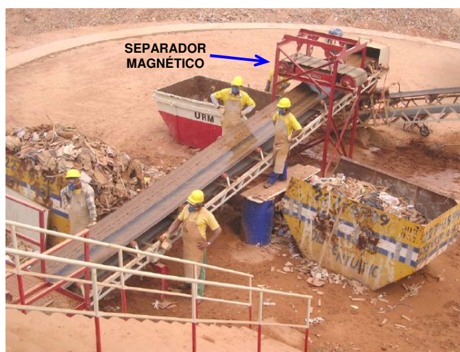
Figura 2.11: Área destinada à catação manual e separação magnética dos agregados reciclados na usina de Campinas (SP). As operações acontecem após a fragmentação do RCD (LEVY, 2005).
