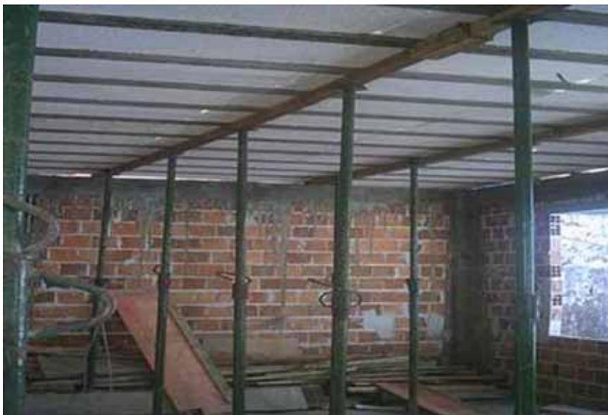
Figura 13 - Escoramento de lajes pré-moldadas
