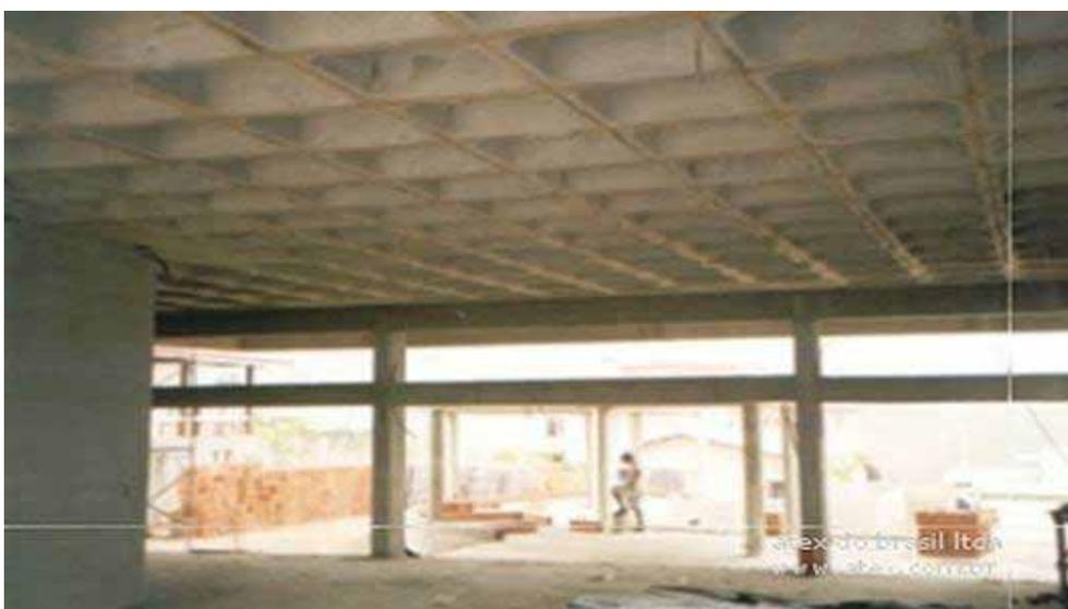
Figura 14 - Laje nervurada sem o elemento de enchimento
