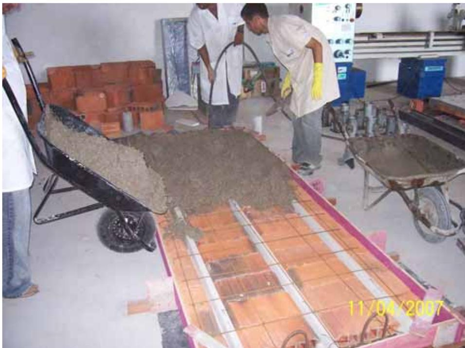
Figura 45 – Concretagem da Laje
