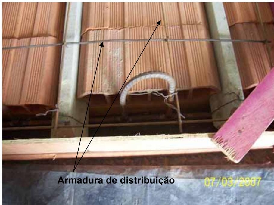
Figura 36 – Armadura de distribuição
