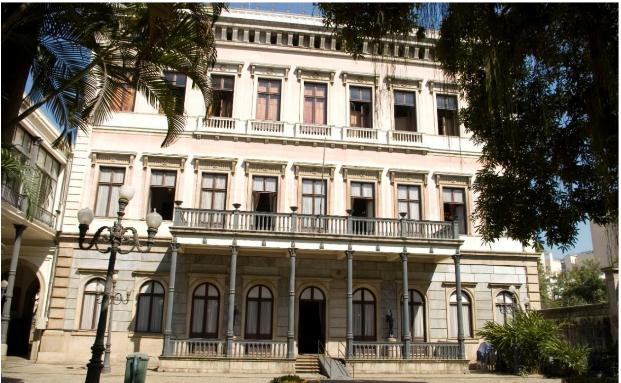
Figura 13: Palácio do Catete, obra do ecletismo com varanda com colunas e guarda-corpos de ferro.
