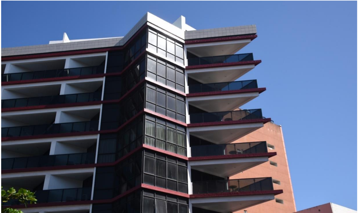
Figura 4: Fachada de edifício com varanda e aberturas sem dispositivo de proteção solar.
