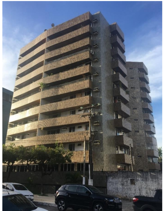
Figura 19: Edifício com varanda reta salientes em Maceió/AL.
