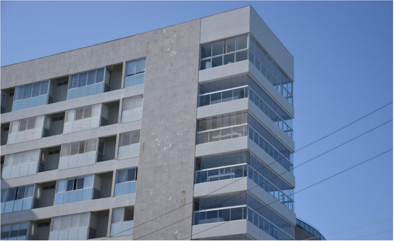
Figura 10: Fachada de edifício com varandas fechadas com vidro.
