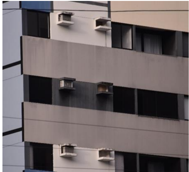
Figura 7: Fachada de edifício com peitoril de alvenaria.
