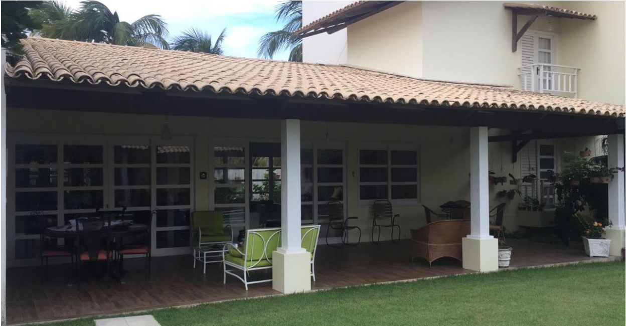
Figura 2: Varanda em edificação unifamiliar.
