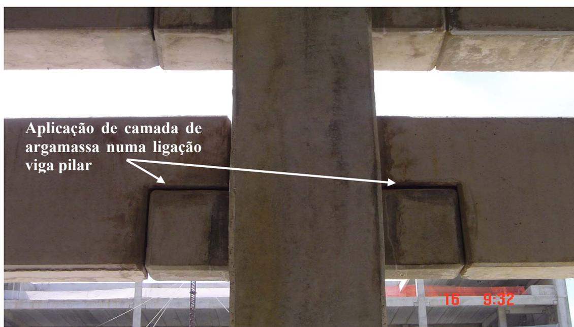
Figura 3.1 – Exemplo de aplicação de junta de argamassa entre elementos pré-moldados
