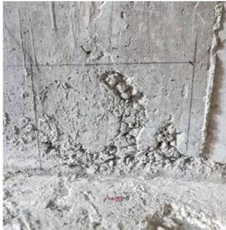
Figura 12 – Concreto desagregado – Fonte: equipedeobra.pini.com.br, 2016
