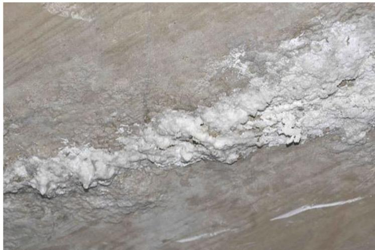
Figura 15 – Eflorescência sobre estrutura de concreto – Fonte: ecivilnet.com, 2016
