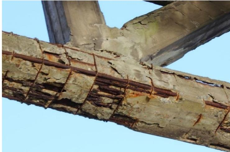
Figura 10 – Concreto armado sobre efeito da corrosão – Fonte:Clubedoconcreto.com.br, 2015
