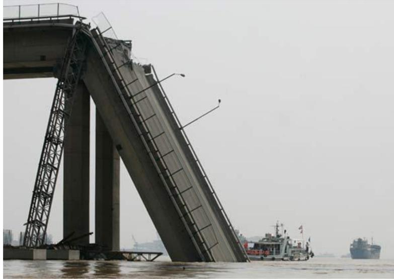
Figura 17 – Ponte atingida por embarcação na china – Fonte: G1.com (2007)
