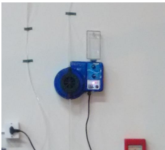
Figura 7 – Bomba hidráulica instalada no sistema.
