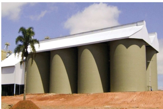
(a) Silos para armazenagem de grãos. Fonte: Ceráça. Disponível em: http://tinyurl.com/zjpdq5h
